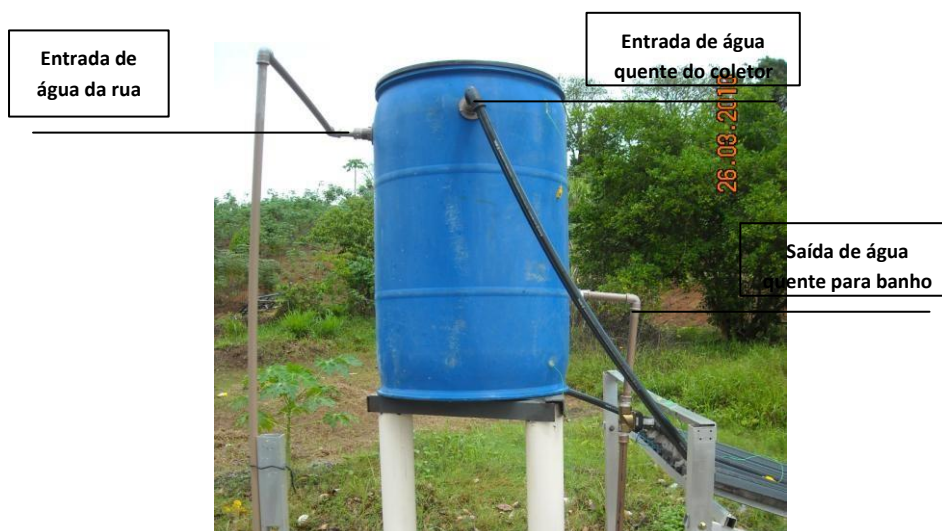
Figura 3.14. Detalhe dos furos no reservatório, vistos lateralmente.
