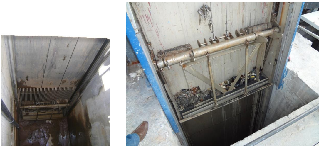
Figura 10: Gradeamento grosseiro mecanizado
