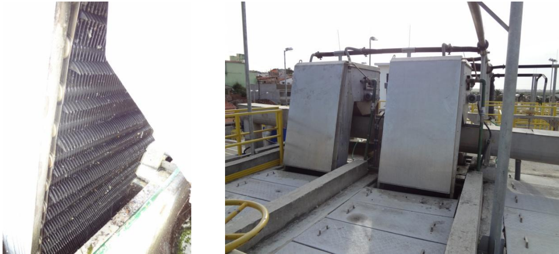
Figura 11: Gradeamento fino mecanizado
