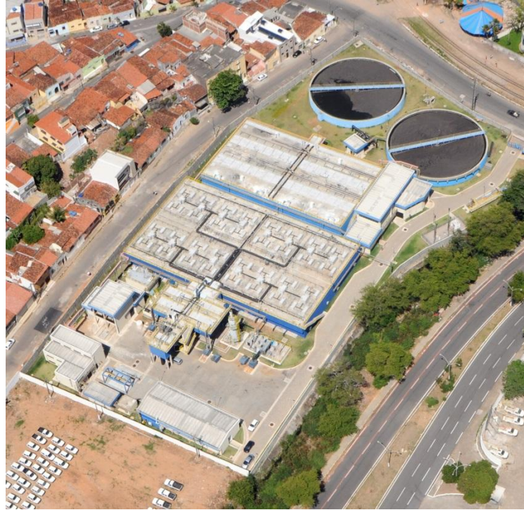
Figura 9: Vista aérea da ETE (Foto: Ronaldo Diniz)
