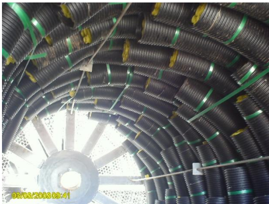
Figura 15: Material suporte dos biodiscos
