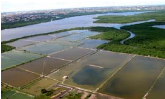
Figura 4.7 – Vista aérea da ETE de Jardim Lola I (FONTE: Ronaldo Diniz, 2005).
