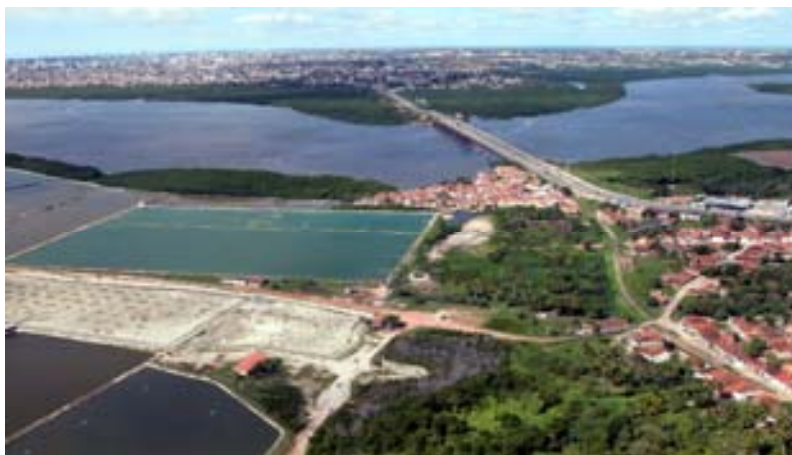
Figura 4.2 – Vista aérea da ETE de Beira Rio (Fonte: Ronaldo Diniz, 2005).
