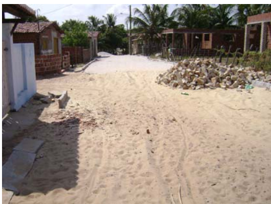
Foto 13 - Rua em processo de pavimentação. Fonte: Clébia Silva, 2008.
