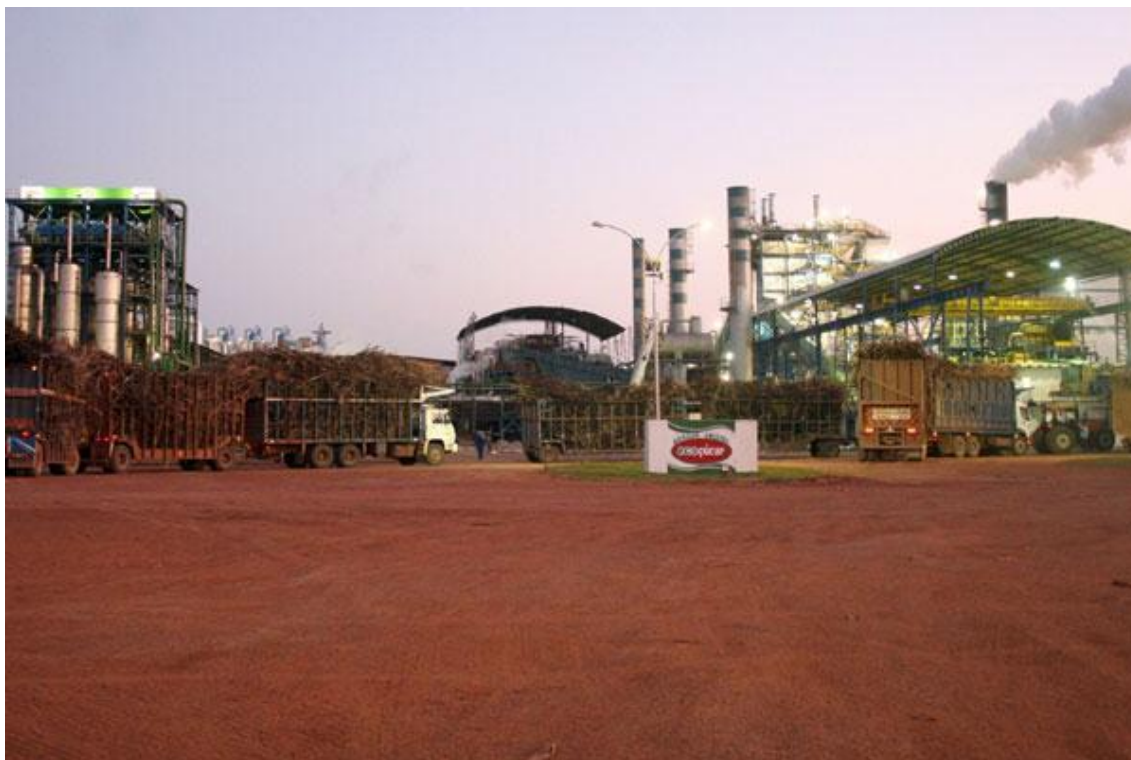
Figura 2 – Usina Vale Verde Baía Formosa/RN.
