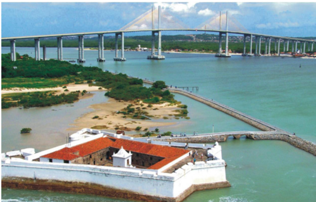
Figura 05: Ponte Nilton Navarro – Ponte de Todos. Foto: Acervo SEMURB.
