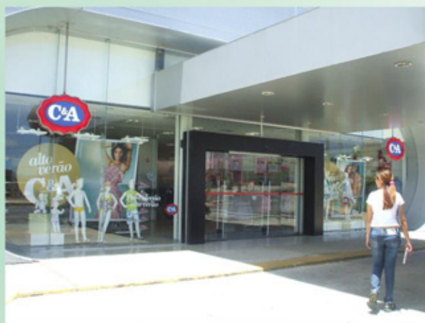
Entrada frontal destacando a C&A
