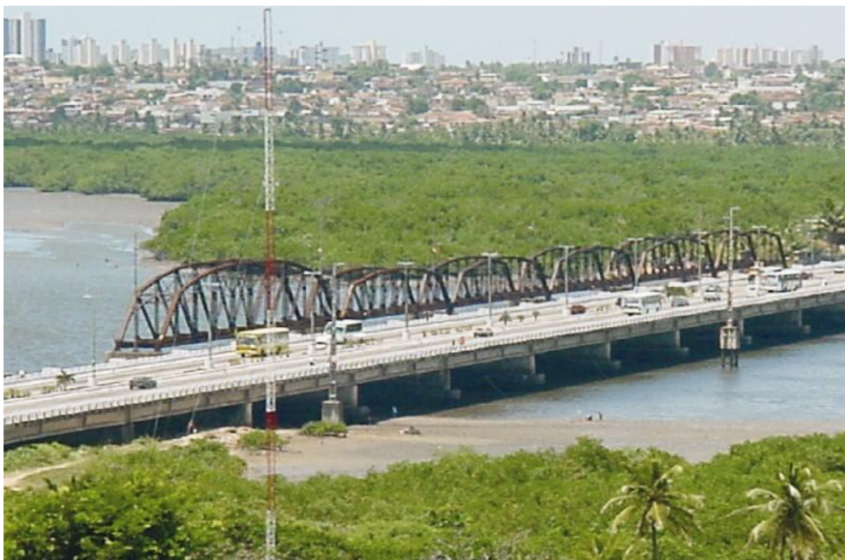
Figura 04: Ponte Costa e Silva – atual Ponte de Igapó.
