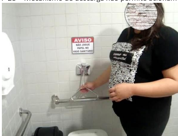
Figura 54. PO-F-28 – Mecanismo de descarga não permite acionamento completo.
