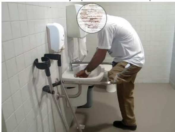
Figura 64. PMU-M-45 – Avaliação positiva da barra de apoio do lavatório.
