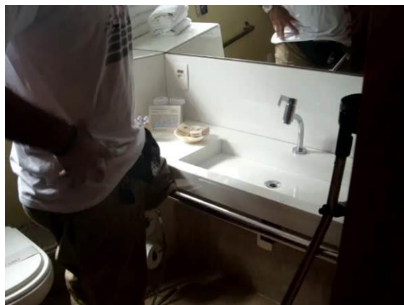
Figura 102. PMU-M-45 – Demonstração da utilização da barra do lavatório.
