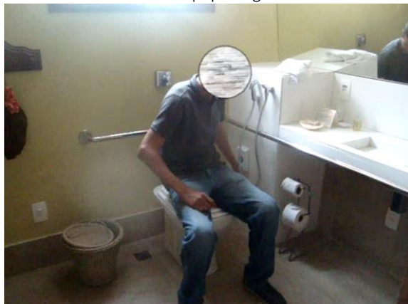
Figura 80. PCT-M-34 – Localização inadequada da ducha e do papel higiênico.
