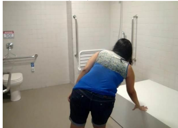
Figura 59. PBV-F-32 – Confusão entre superfície para troca de roupas e parede devido à cor.
