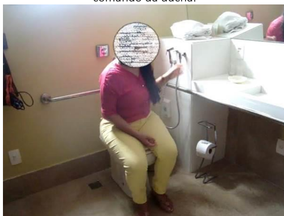
Figura 99. PBV-F-32 – Dificil compreensão do comando da ducha.
