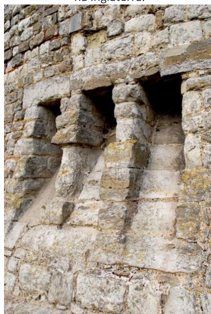
Figura 5. Rampa na parede externa do castelo Haleigh, na Inglaterra.
