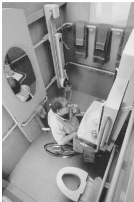
Figura 13. Banheiro com acessórios móveis.
