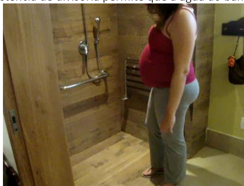
Figura 87. PG-F-29 – Inexistência de divisória permite que a água do banho molhe todo o banheiro.
