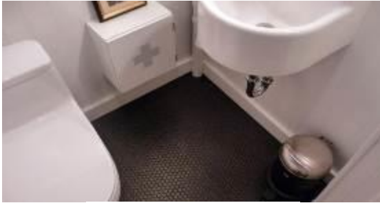
Figura 19. Piso antiderrapante e peças com bordas arredondadas
