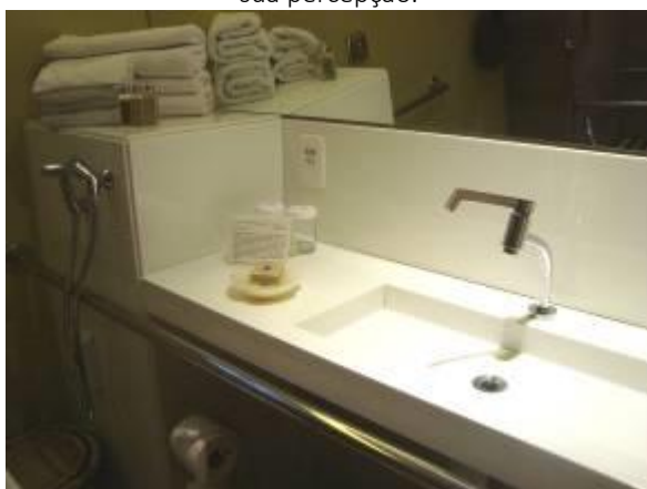
Figura 73. Cuba e bancada da mesma cor dificultam a sua percepção.
