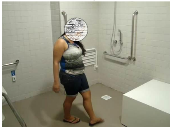
Figura 60. PBV-F-32 – Área de banho pequena e ausência de elemento para delimitá-la.
