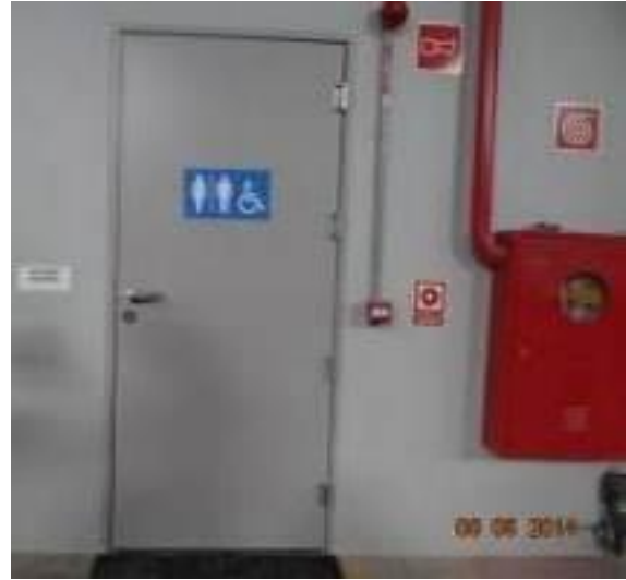
Figura 18. Sinalização da porta de forma pictórica, verbal e tátil.
