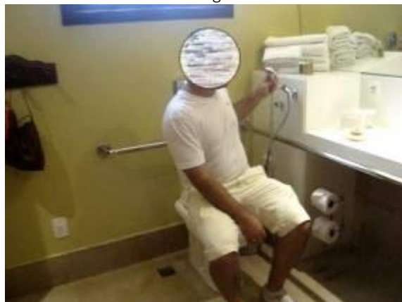
Figura 76. PSR-M-26 – Localização inadequada da ducha higiênica
