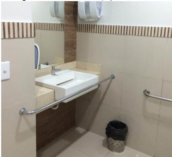
Figura 24. Lavatório com espaço livre inferior.
