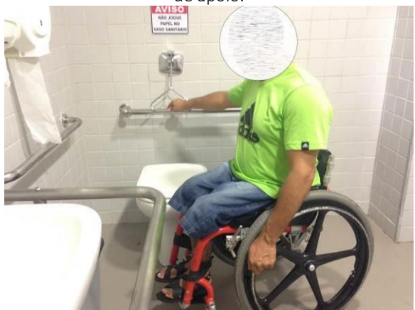
Figura 69. PCR-M-33 – Conflito entre alavanca e barra de apoio.
