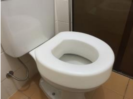
Figura 22. Bacia sanitária com apoio para costas.
