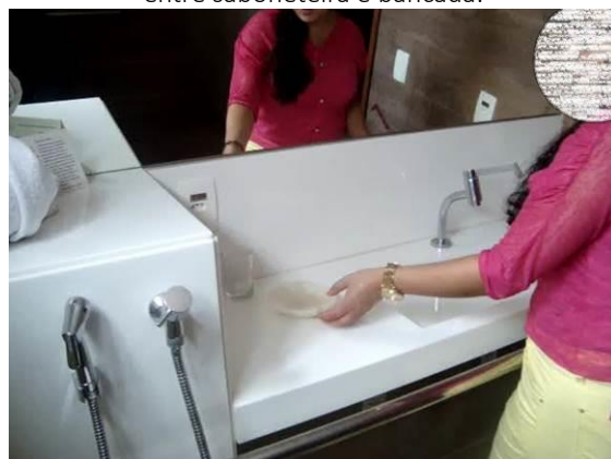
Figura 98. PBV-F-32 – Ausência de contraste de cor entre saboneteira e bancada.
