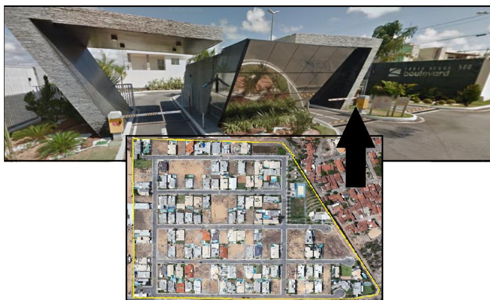
Figura 17 - Condomínio Ponta Negra Boulevard.
