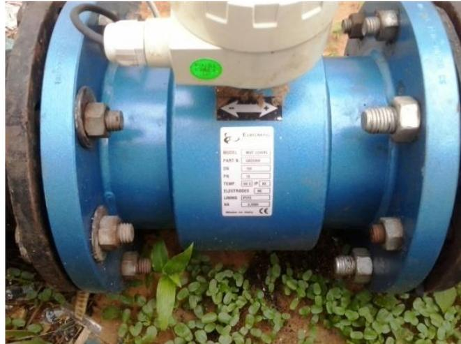
Figura 19 - Placa de identificação e indicação do sentido de fluxo.
