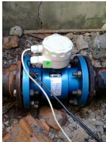
Figura 20 - Caixa de derivação na parte superior do medidor.
