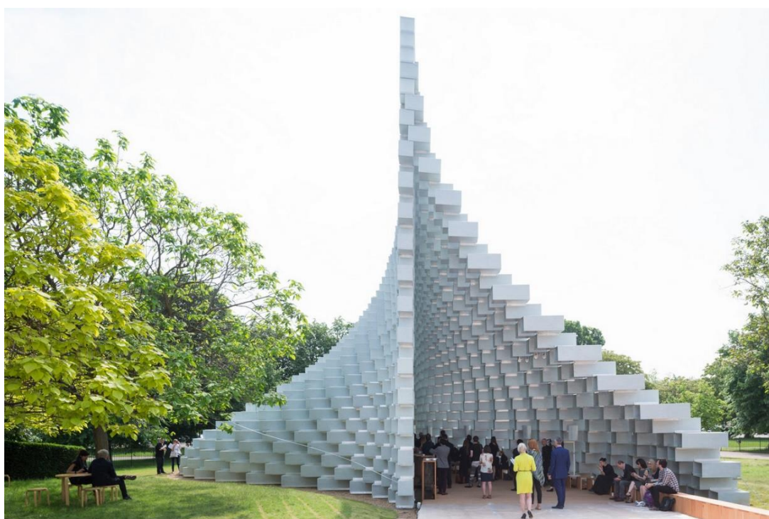
Figura 42: Pavilhão Serpentine Fonte: Site oficial do BIG
