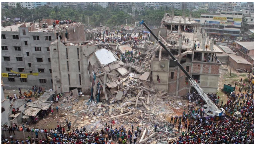
Figura 12 - Desastre no Edifício Rana Plaza, em 2013. O prédio de oito pisos, abrigava fábricas e um centro comercial em Savar, na periferia de Daca, a capital do Bangladesh. Foto/Reprodução: Zakir Hossain Chowdhury.
