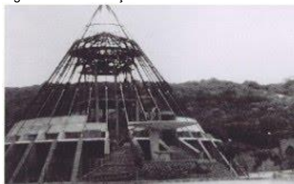
Figura 50 - Construção do Santuário do Lima
