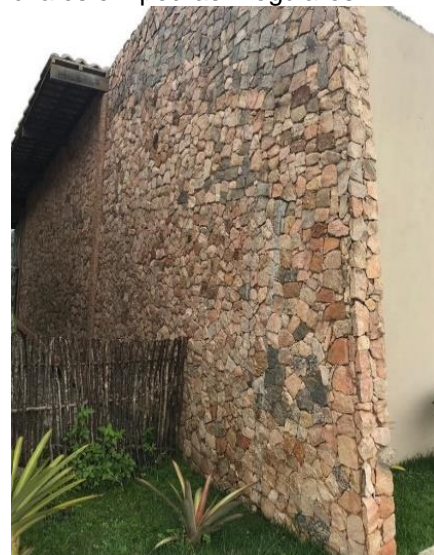
Figura 40 - Paredes laterais dos chalés em pedras irregulares
