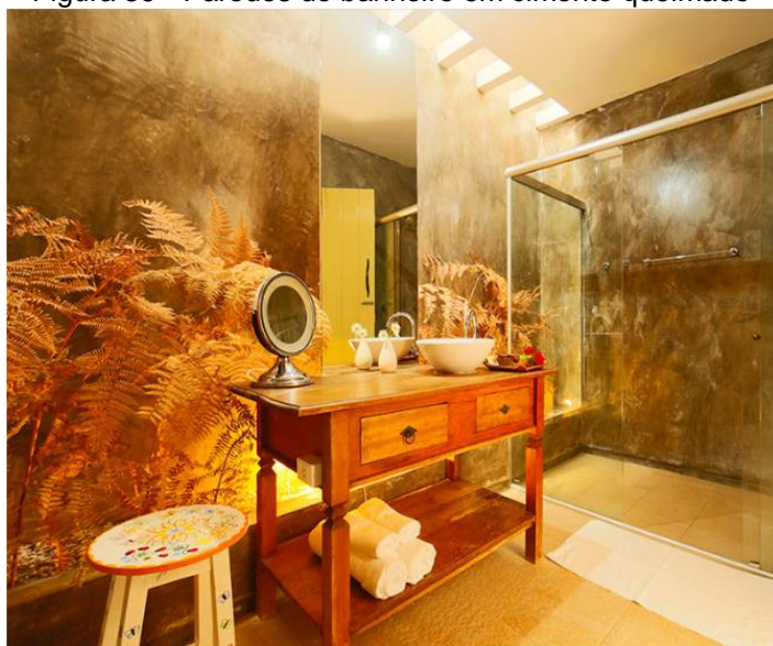
Figura 39 - Paredes do banheiro em cimento queimado
