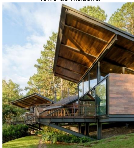
Figura 44 - Grande beiral em balanço com forro de madeira
