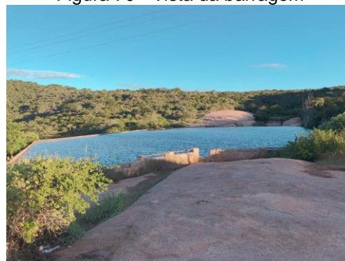
Figura 70 - Vista da barragem
