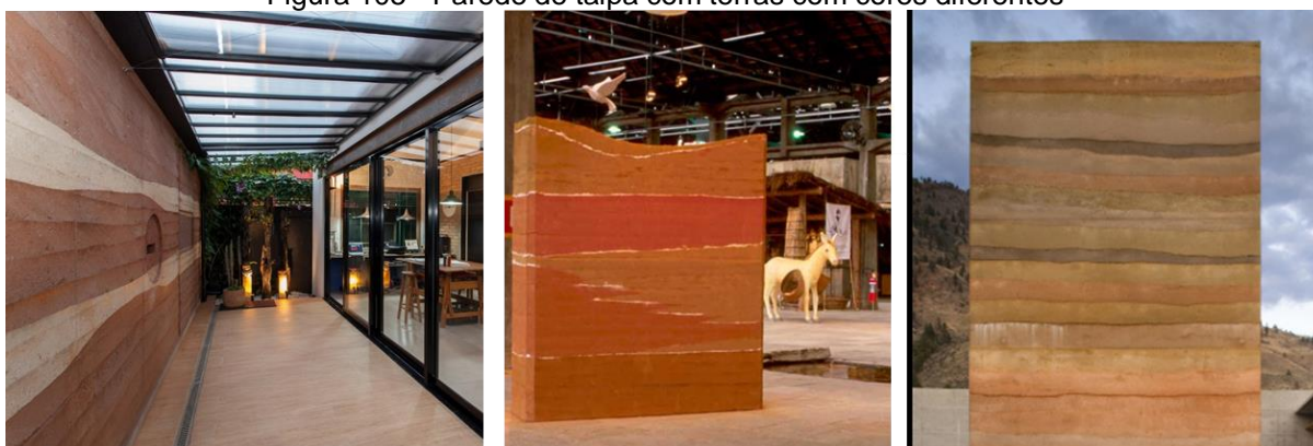
Figura 105 - Paredes de taipa com terras com cores diferentes
