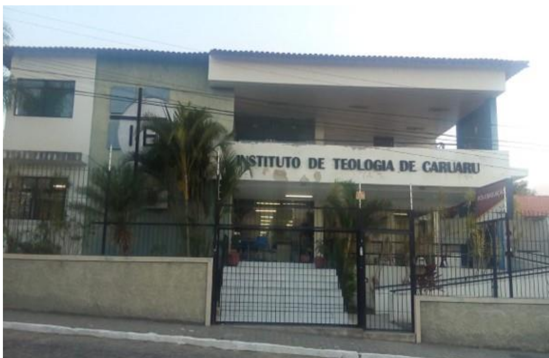
Figura 4: Fachada do prédio onde funcionou o ITEC.
