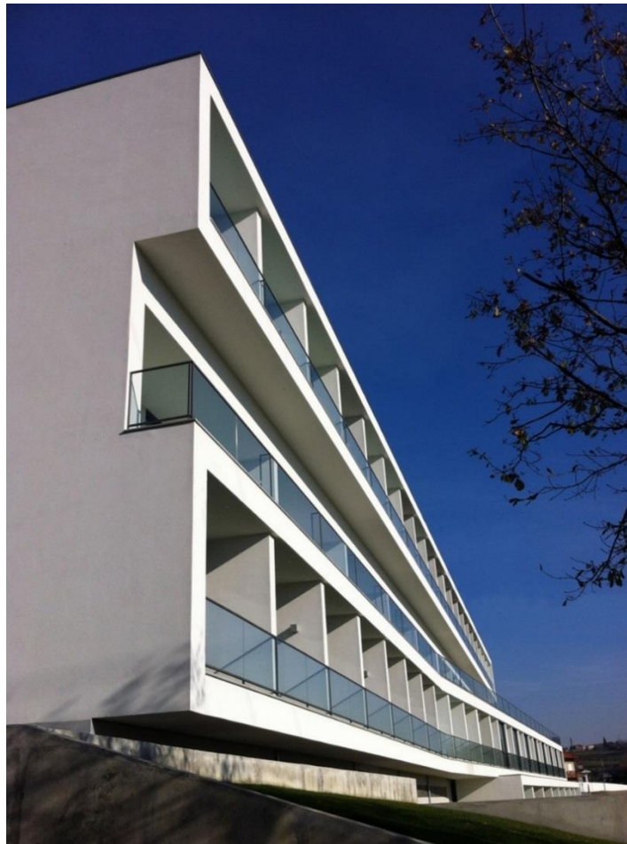
Figura 18: Edifício Residencial para Idosos em Santo Tirso, Portugal.
