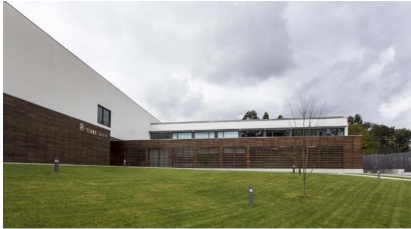
Figura 24, 25 e 26: Edifício Residencial para Idosos – Áreas de convívio e entorno, Fachada das habitações (dia e noite).
