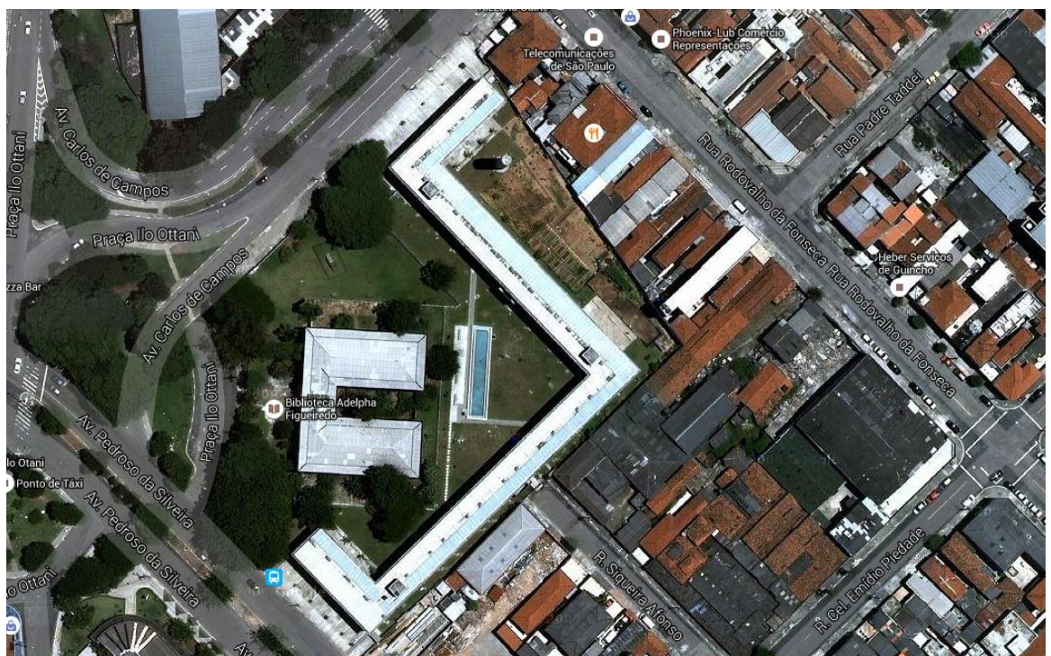
Figura 33: Implantação do edifício – Avenida Carlos de Campos com Avenida Pedroso da Silveira.
