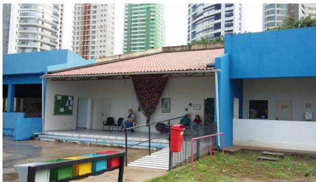
Figura 07: Edifício do Clube do Idoso – Recepção.
