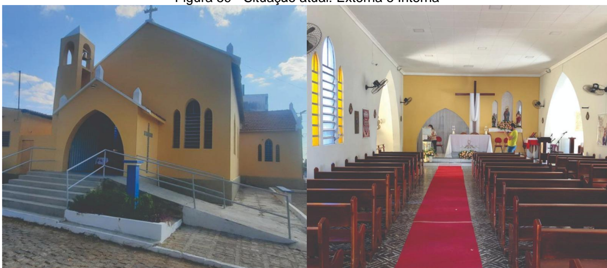
Figura 59 - Situação atual: Externa e Interna
