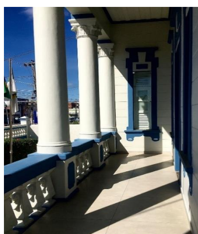
Guarda-corpo e coluna jônica
