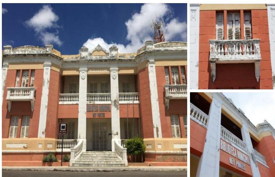
Figura 37 – Biblioteca Municipal Ney Pontes Fonte: Elaborado pelo autor (2022)
