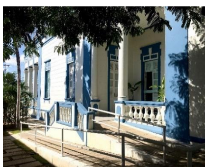
Fachada lateral esquerda
