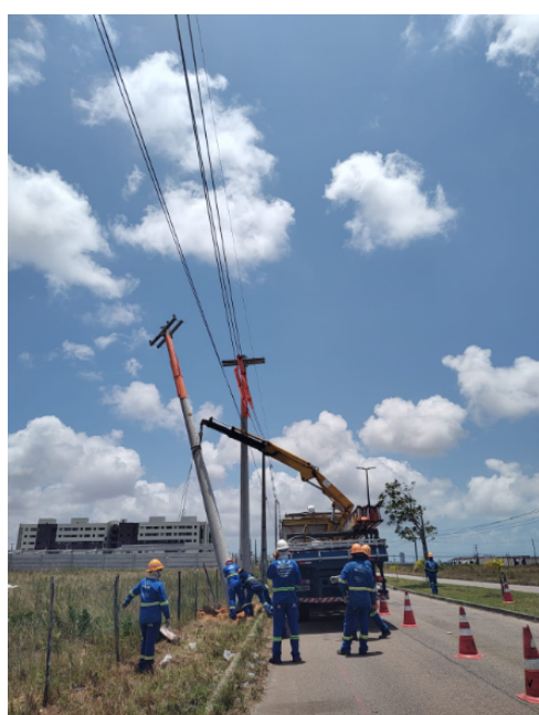
(a) Início da Instalação
