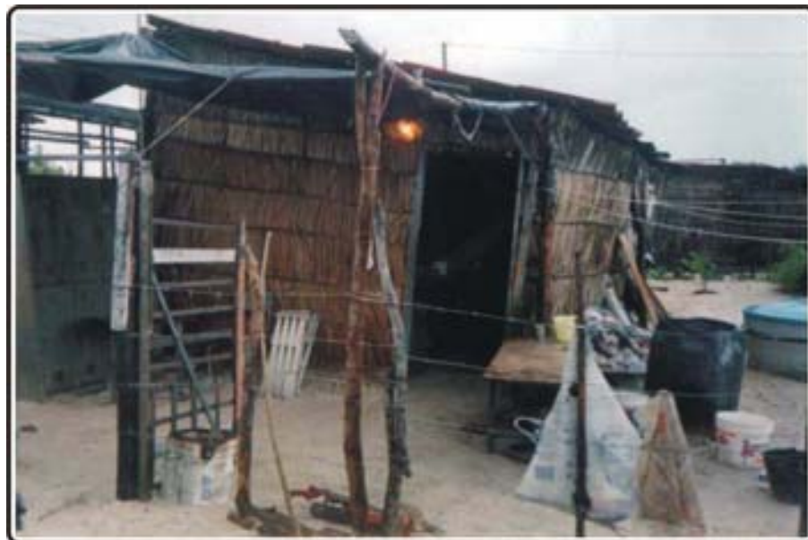
Fotografia 4: Aspecto da falta de infra-estrutura na Comunidade África Fonte: MELO, agosto / 2004.
