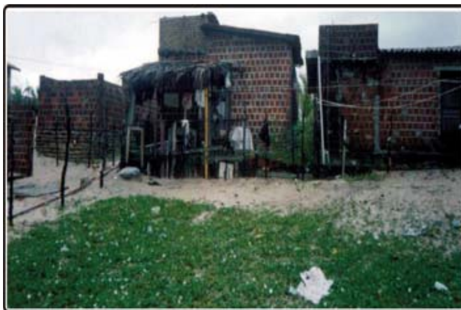
Fotografia 1 – Aspectos de residências da Comunidade África. Fonte: MELO, julho / 2004.
