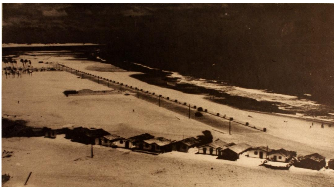
Figura 7 - Início da construção da Avenida Circular (1946)
