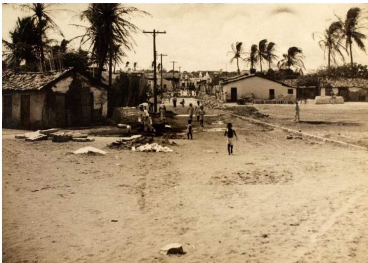
Figura 28 – Trecho da rua Expedicionário José Varela antes das obras de pavimentação (1946)
