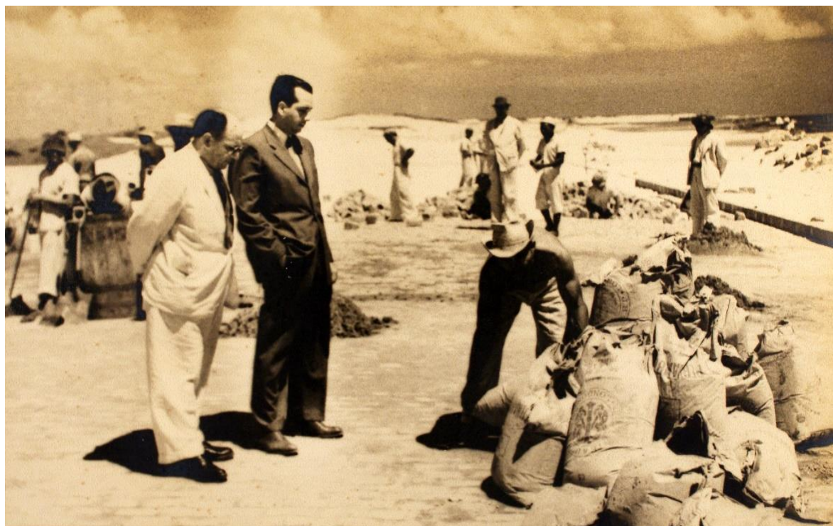
Figura 26 – Silvio Pedroza visitando as obras da Avenida Circular (1946).
