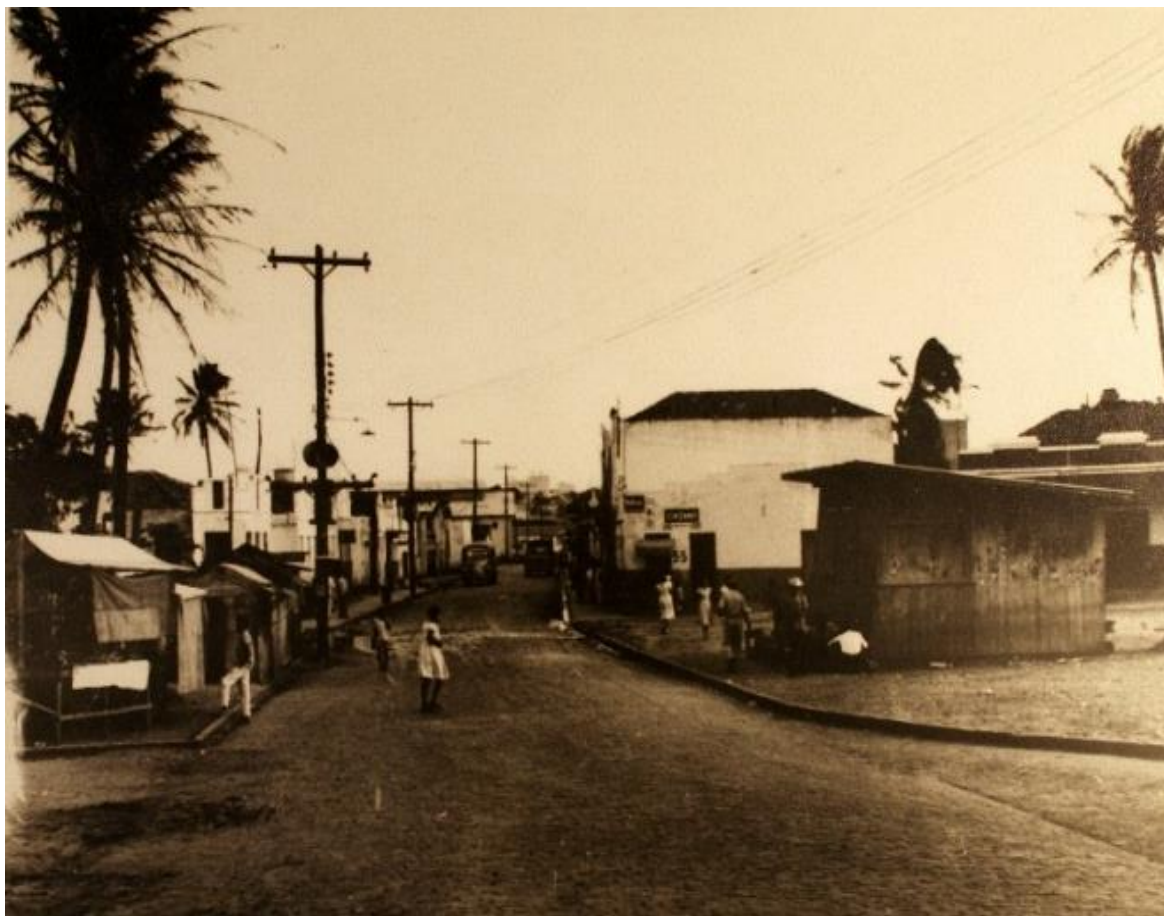
Figura 29 – Trecho da rua Expedicionário José Varela depois das obras de pavimentação (1948)
