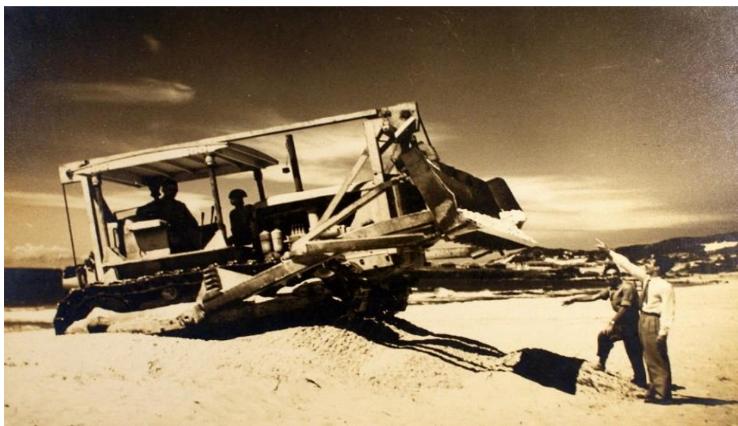
Figura 8 – Bulldozer mastigando a areia para fazer surgir a Avenida Circular, 1946.
