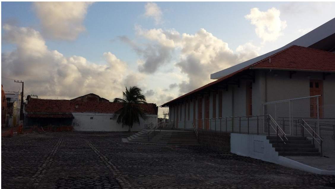
FIGURA 71: imagem da interação entre a edificação antiga e o nova edificação
