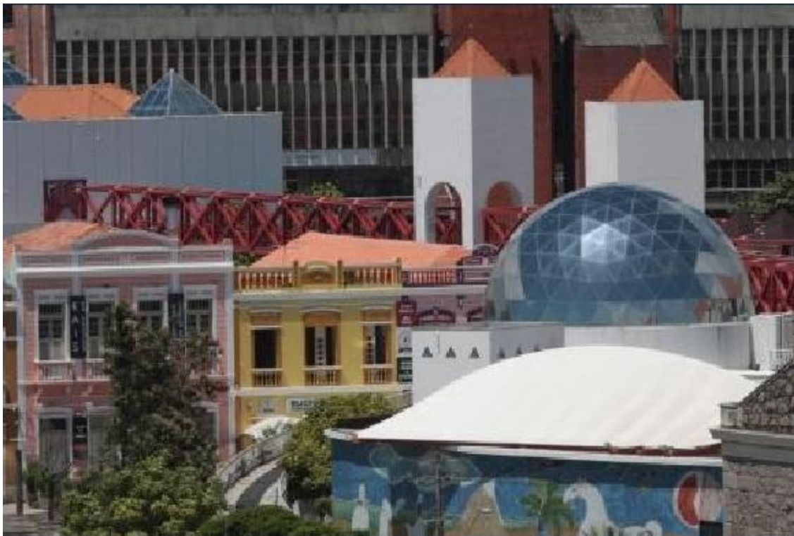
FIGURA 9: Interação entre a cúpula de vidro, a passarela e os casarões remanescentes
