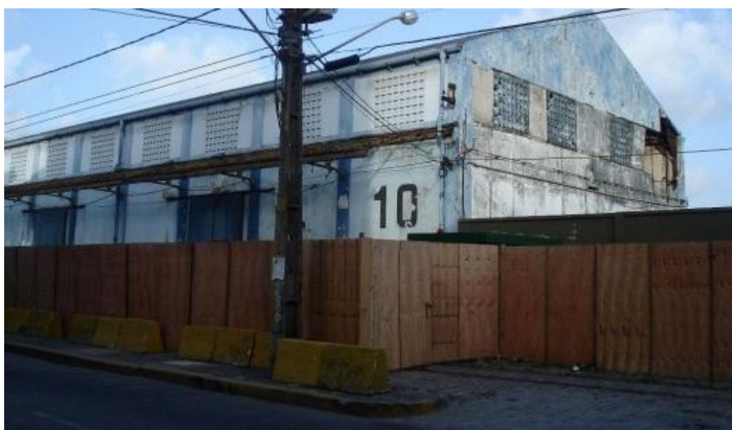
FIGURA 16: Armazém 10, pouco antes de sua demolição
