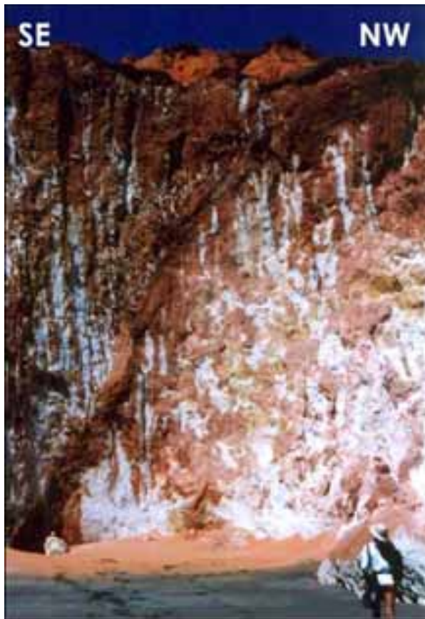
Figura 5.57 – Nível de intemperismo 1 preenchendo plano de falha D_{2d} na localidade de Vila Nova. Ver figura 5.20 para localização.
