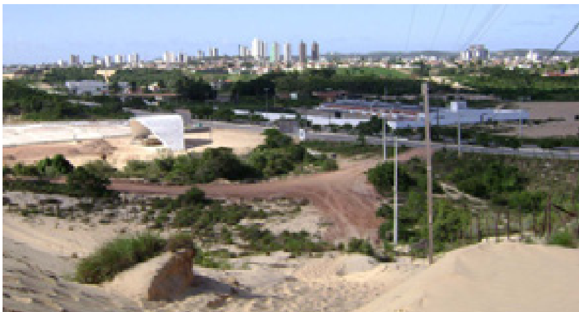
Figura 61 – Área construída na ZPA-1 - ao fundo habitações com alto padrão de construção Fonte: Diagnóstico Ambiental da ZPA 1 contido na proposta do respectivo Plano de Manejo.
