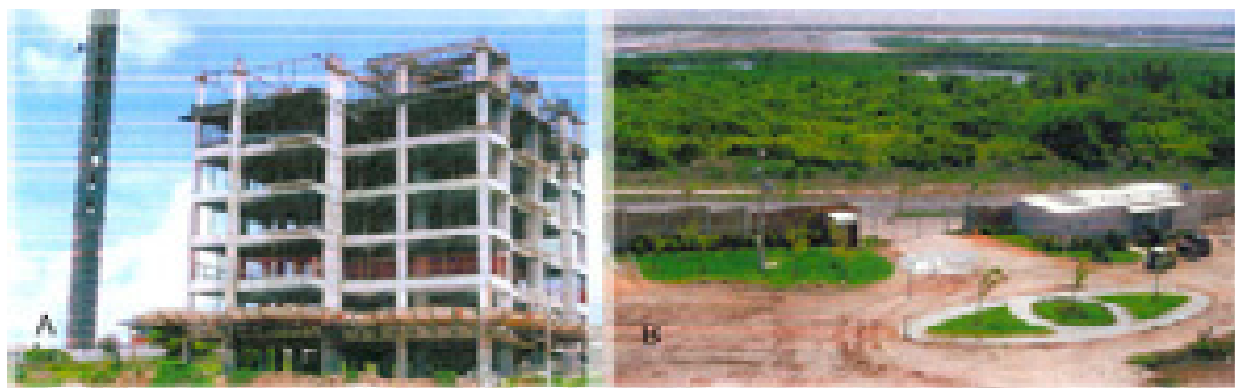
Figura 114 – Construção do empreendimento Riverside.
