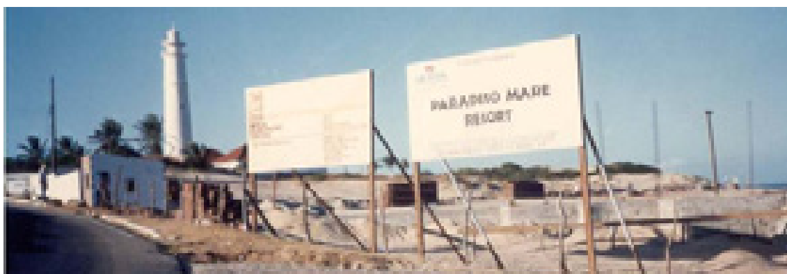
Figura 42 – Primeiras ações para construção do empreendimento Paradiso Mare Resort na Via Costeira. Vista com o Farol de Mãe Luiza ao fundo. Fonte: GEHAU DARQ (1992).
