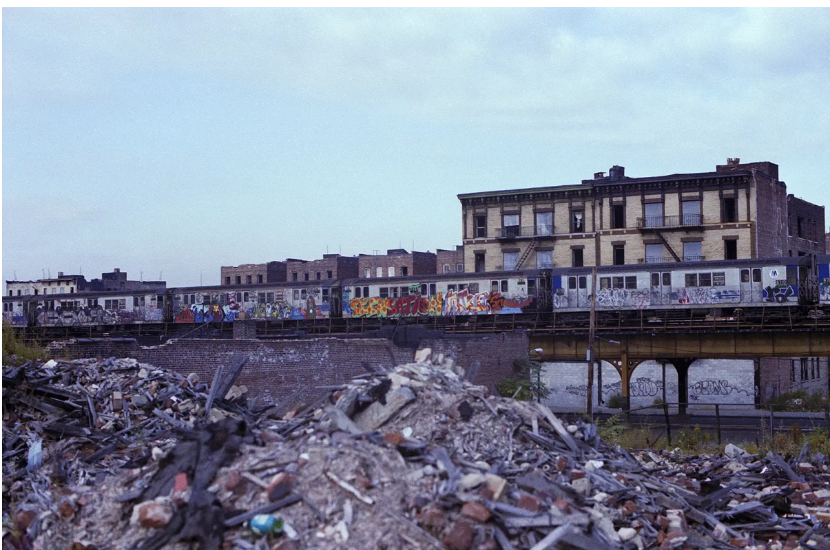
Figura 1 - Edifícios destruídos e abandonados ao longo da Avenida Hoe e a linha do ITR no Bronx (1981)
