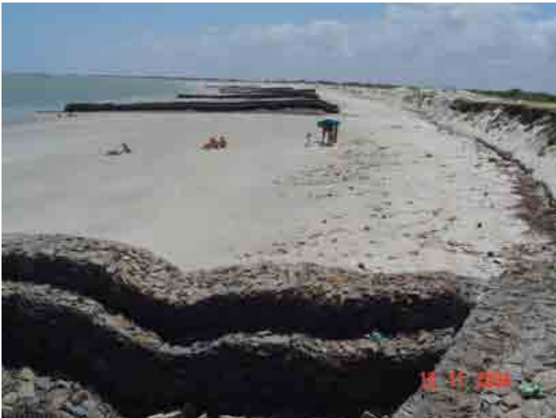
Figura 3.21 – Fotografia mostrando o efeito erosivo em cima dos gabiões na praia de Camapum, não acumulando sedimento neste período.
