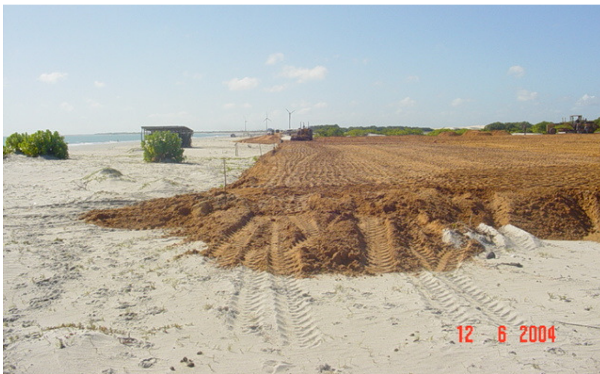
Figura 3.18 – Fotografia do início da obra para instalação do poço avançado 7SER13DRNS da PETROBRAS em 2004.
