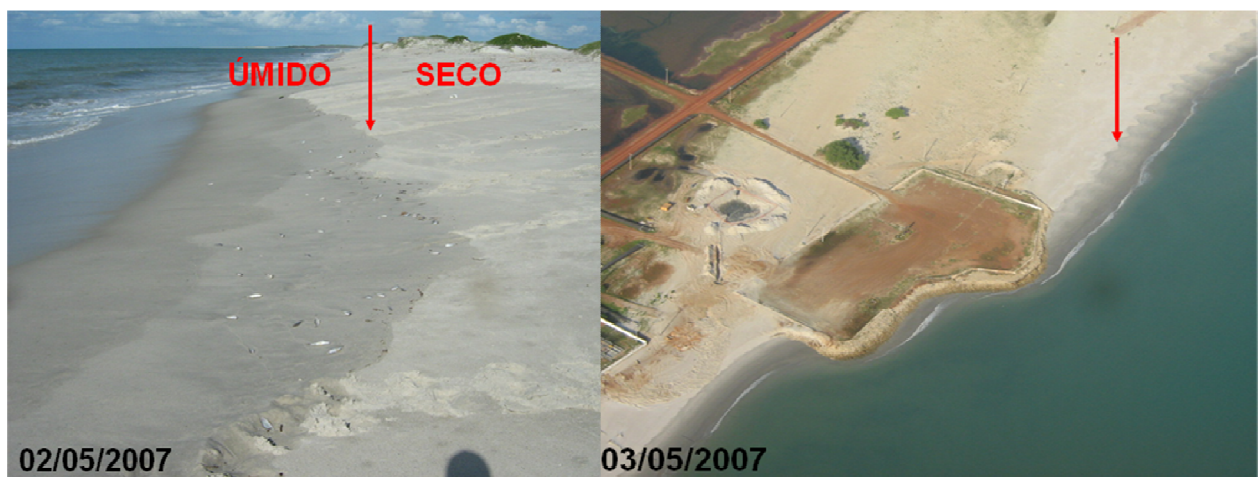
Figura 1.14 – Fotografias mostrando o limite das áreas úmidas e secas vistas in loco .
