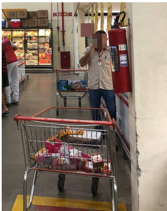
Figura 29 Exemplo de obstrução de equipamento de SCI na área do salão de vendas
