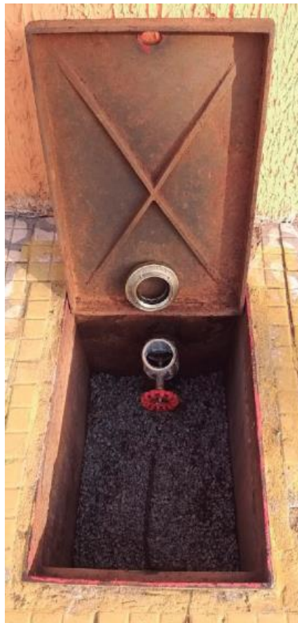
Figura 19 Hidrante de recalque
