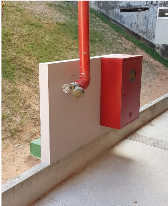
Figura 16 Hidrante simples com abrigo para duas mangueiras
