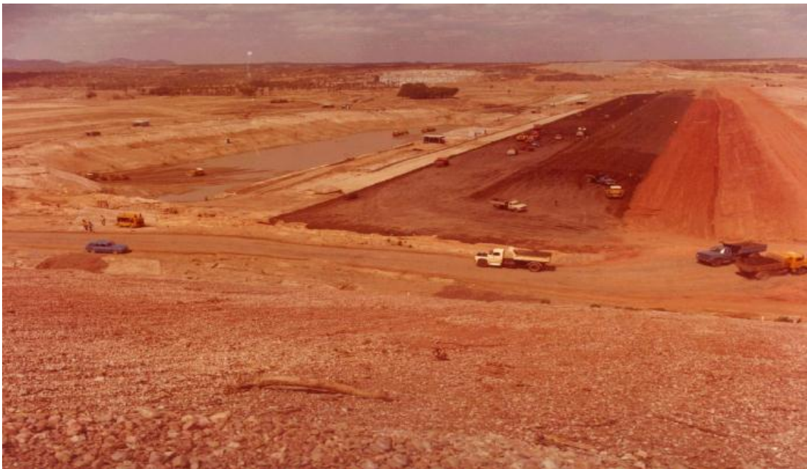
Figura 3.5 – Vista da construção da barragem central e início da escavação do cut-off (Rocha, 2003)
