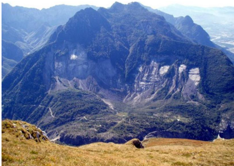
Figura 2.21 – Vista da superfície de ruptura, Vajont (Barla & Paronuzzi, 2013)
