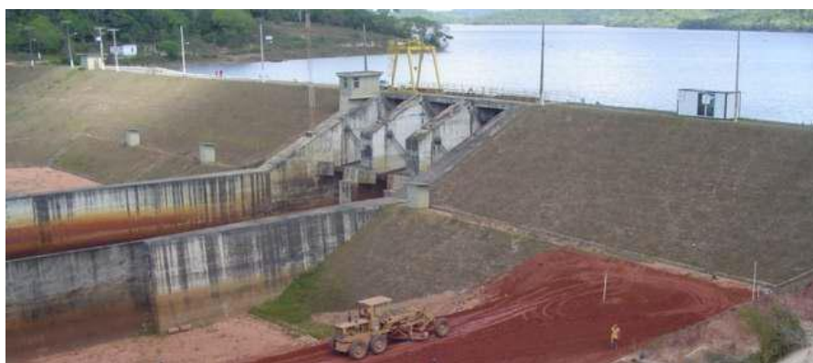
Figura 5.25 – Maciço de terra e extravasor de concreto da barragem de Santa Helena (Oliveira, 2008)
