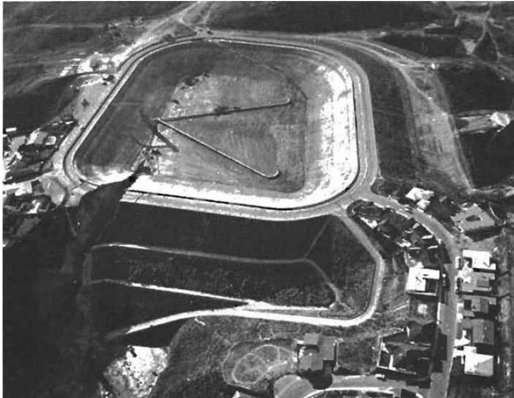
Figura 2.23 – Vista aérea da barragem após a ruptura (James et al. , 1988)
