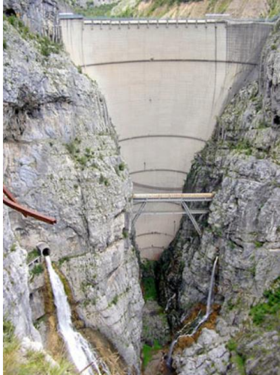
Figura 2.20 – Arco de dupla curvatura, barragem de Vajont (Barla & Paronuzzi, 2013)
