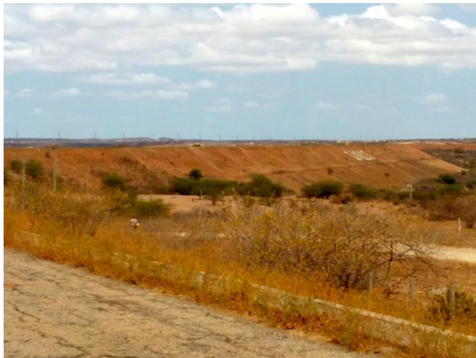
Figura 3.1 – Vista do talude de jusante da barragem de Açu (Freire, 2016)
