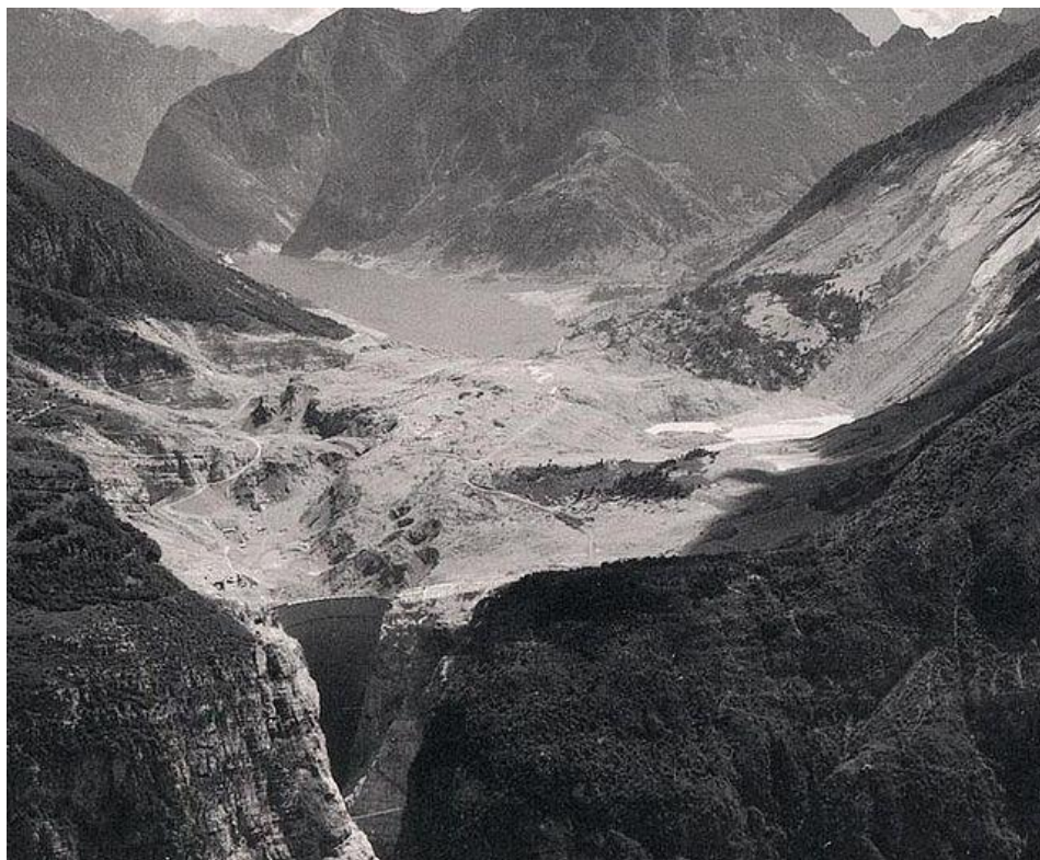
Figura 2.22 – Vista aérea da barragem de Vajont após o acidente (Imagem de domínio público disponível em http://www.landslideblog.org/2008/12/vajont-vajont-landslide-of-1963.html e acessada em 08/01/2017)
