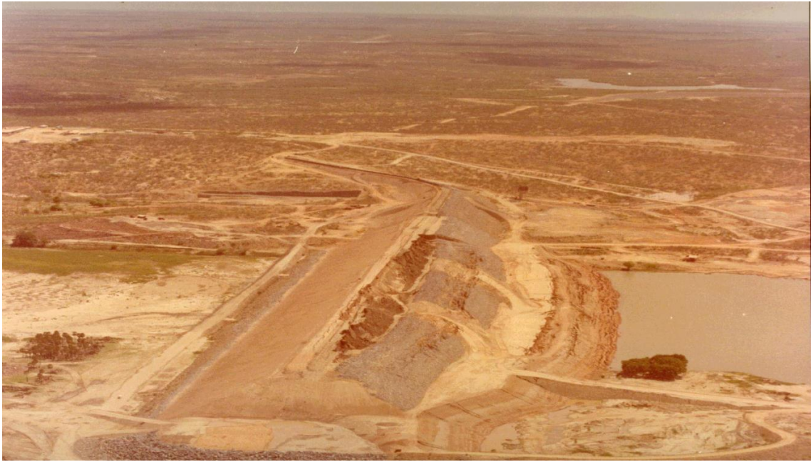
Figura 3.10 – Vista aérea do talude rompido (Rocha, 2003)
