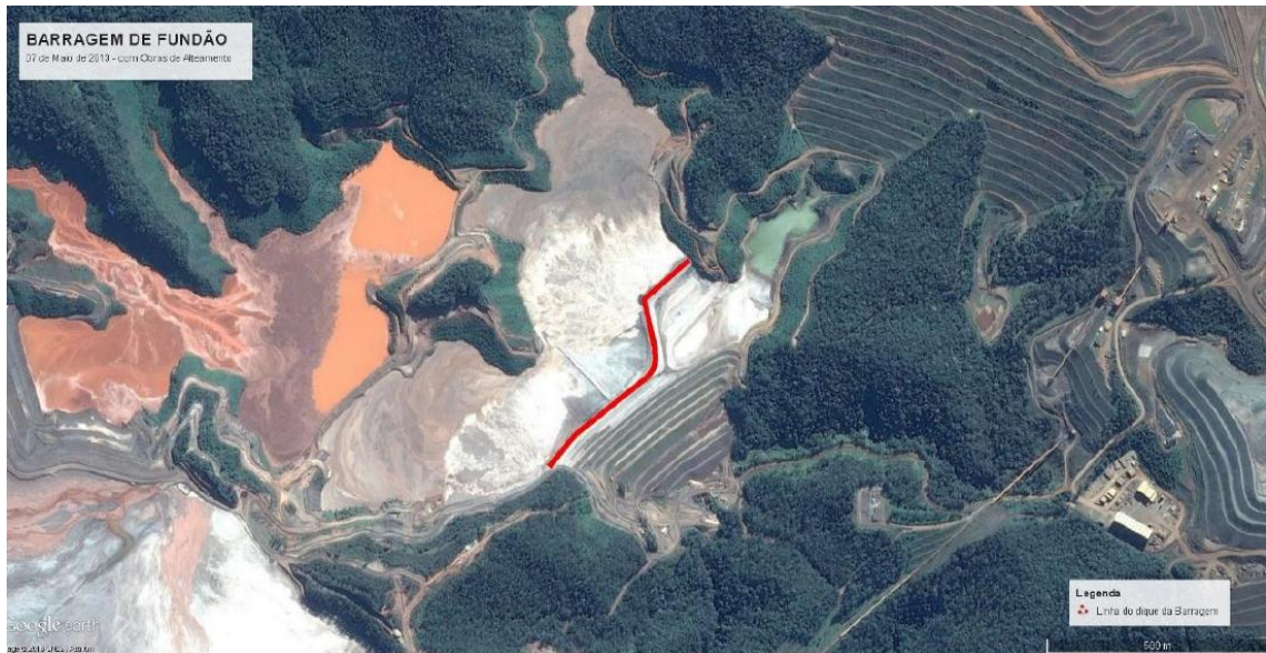
Figura 2.29 – Barragem de Fundão em Maio de 2012 (Google Earth apud Prudente et al. , 2016)
