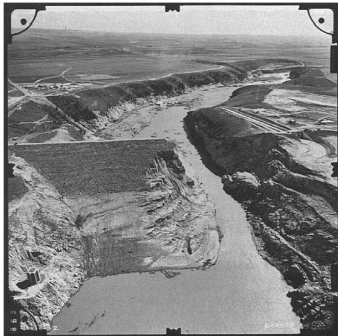
Figura 2.26 – Vista da Barragem de Teton após a ruptura (Seed & Duncan, 1987)
