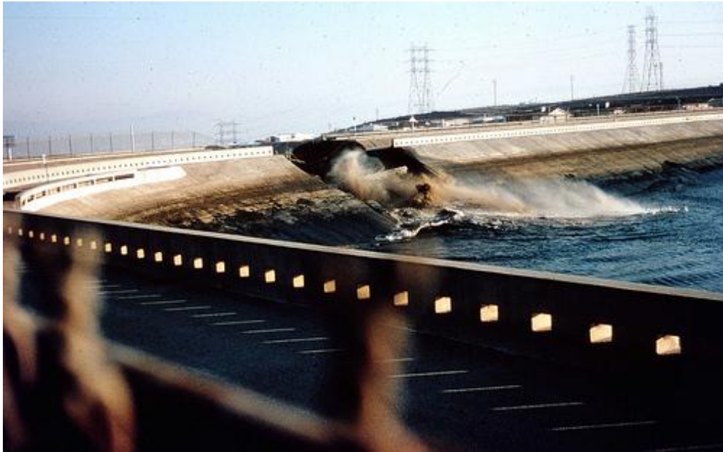
Figura 2.24 – Fotografia da barragem após a ruptura (Keylon, 2011)
