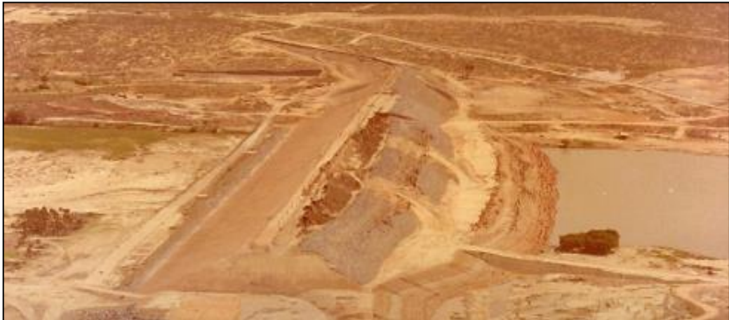
Figura 19 - Vista aérea do talude após a ruptura.
