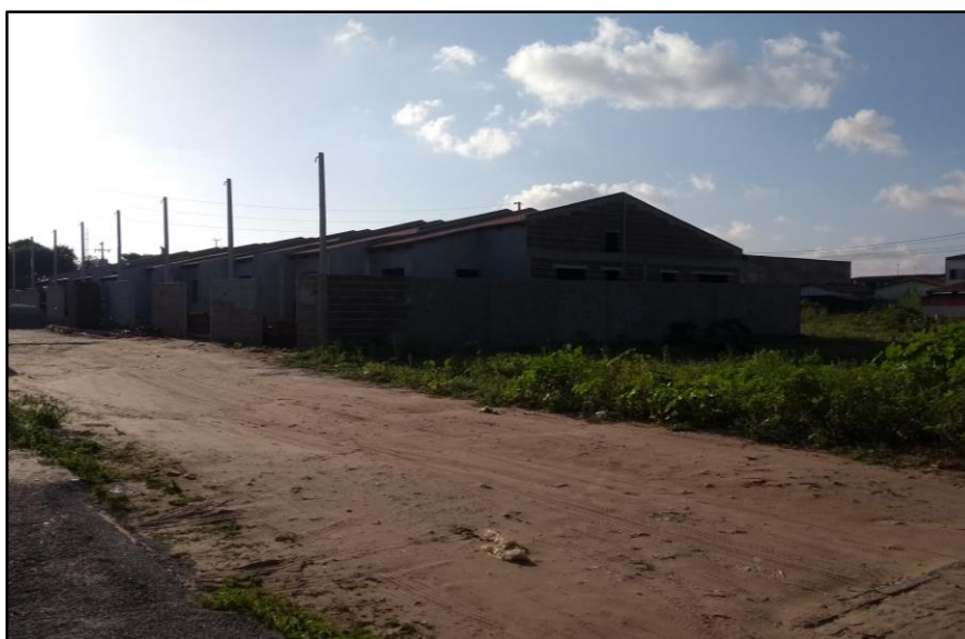
Figura 04 - Construção de casas no conjunto Cidade das Rosas.
