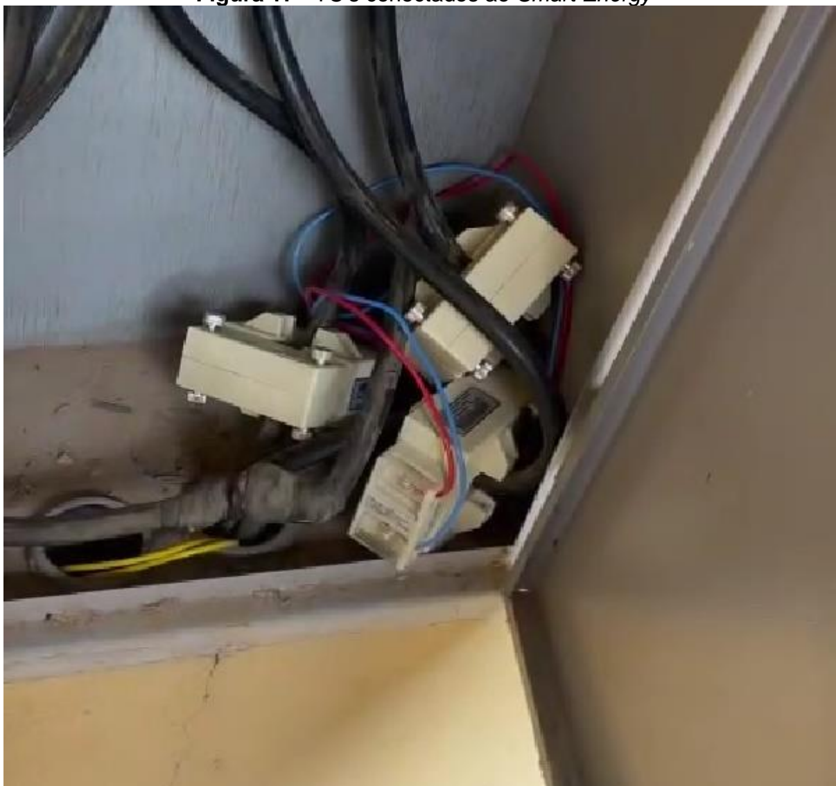
Figura 17 - TC's conectados ao Smart Energy
