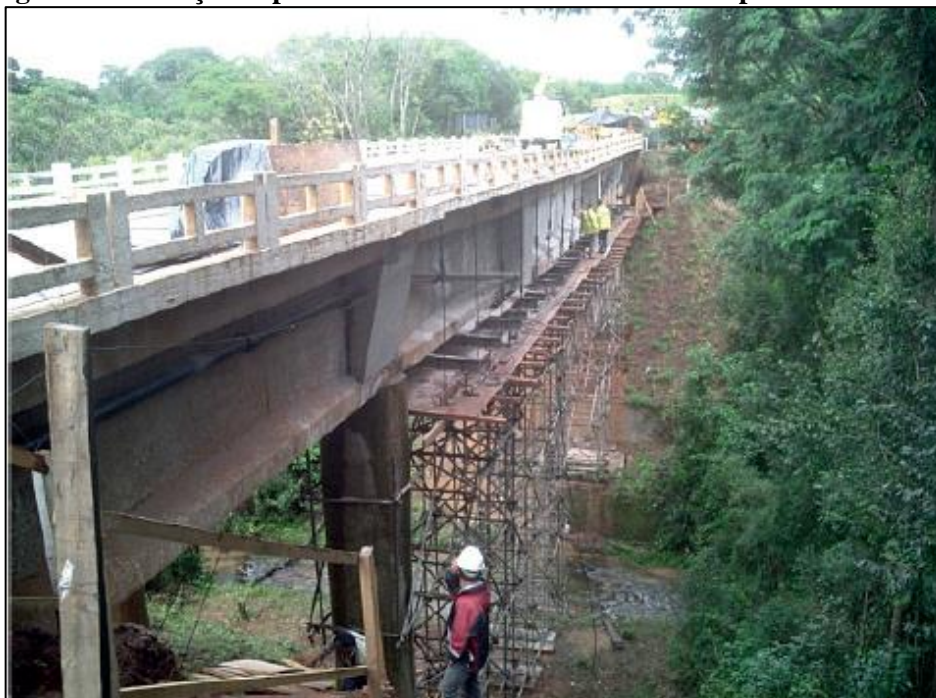
Figura 5 - Reforço em ponte de concreto armado utilizando protensão externa
