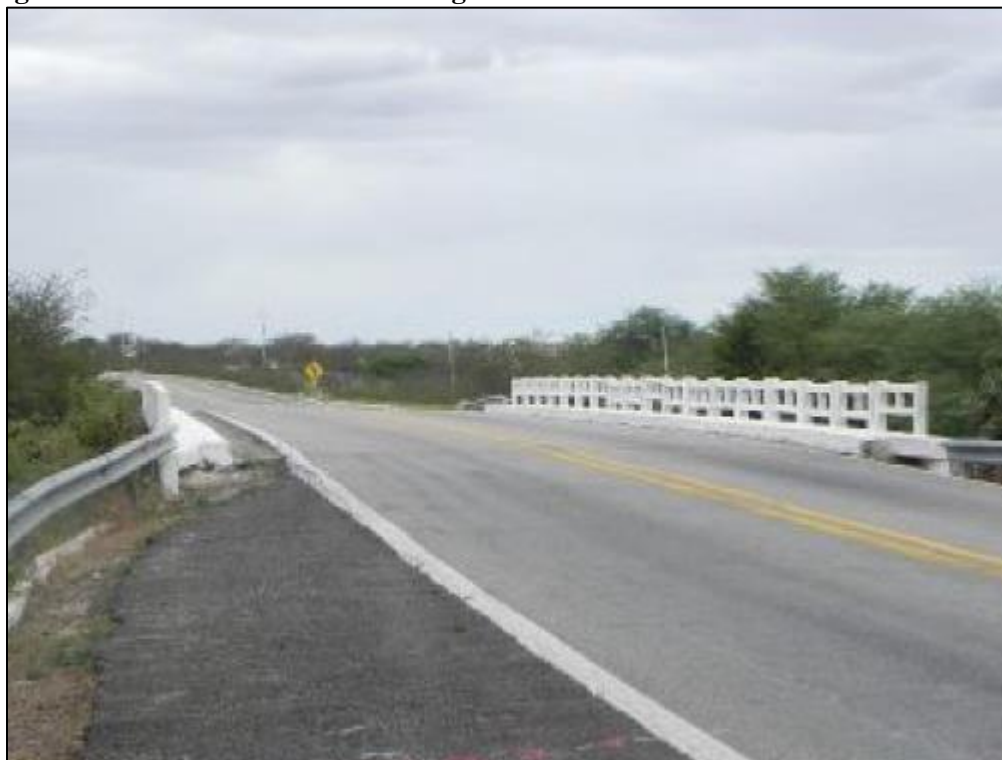
Figura 46 - Ponte sobre o Rio São Miguel - Rodovia BR 304/RN - Vista do tabuleiro
