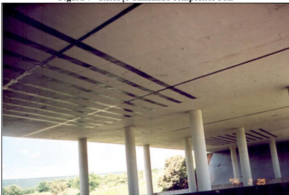
Figura 7 - Reforço utilizando compósitos FRP
