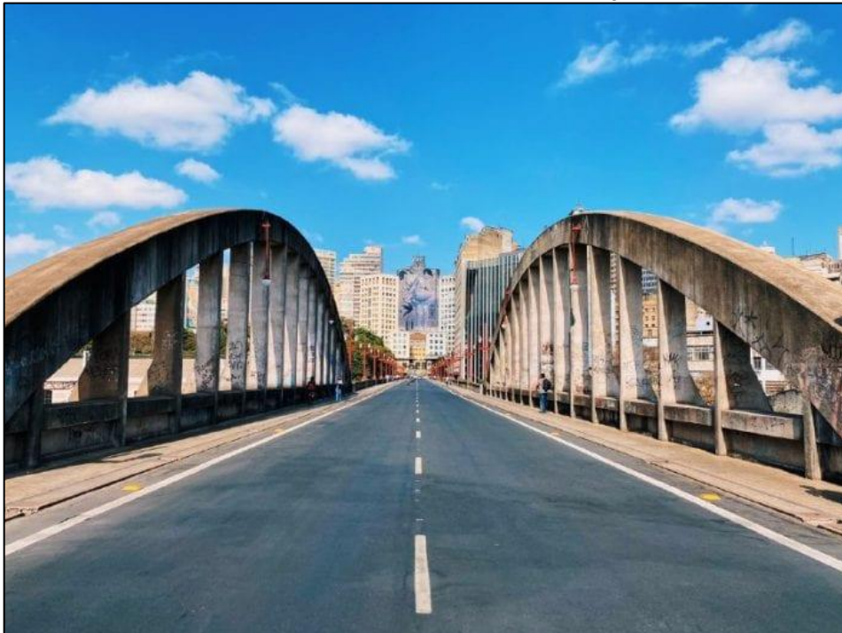
Figura 1 – Viaduto Santa Tereza – Belo Horizonte/MG – Primeira obra da América Latina a utilizar fibra de carbono como reforço estrutural.
