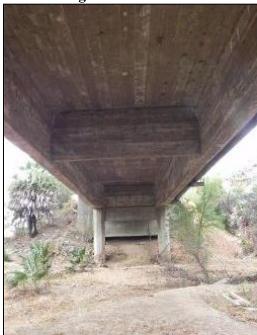
Figura 47 - Estrutura da Ponte sobre o Rio São Miguel
