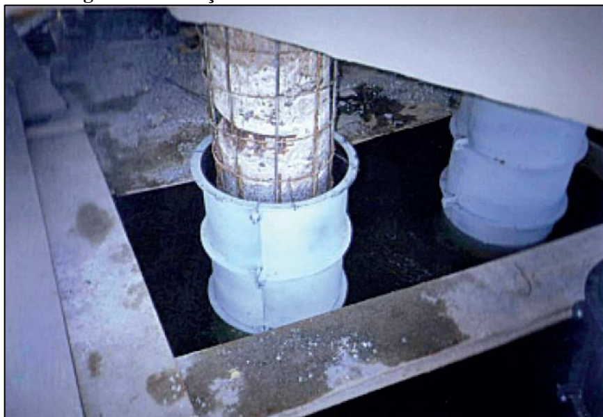
Figura 4 - Reforço utilizando técnica de encamisamento
