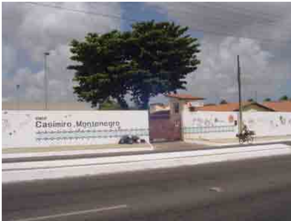
Figura 06: Foto da parte externa da EMEIF Casimiro Montenegro
