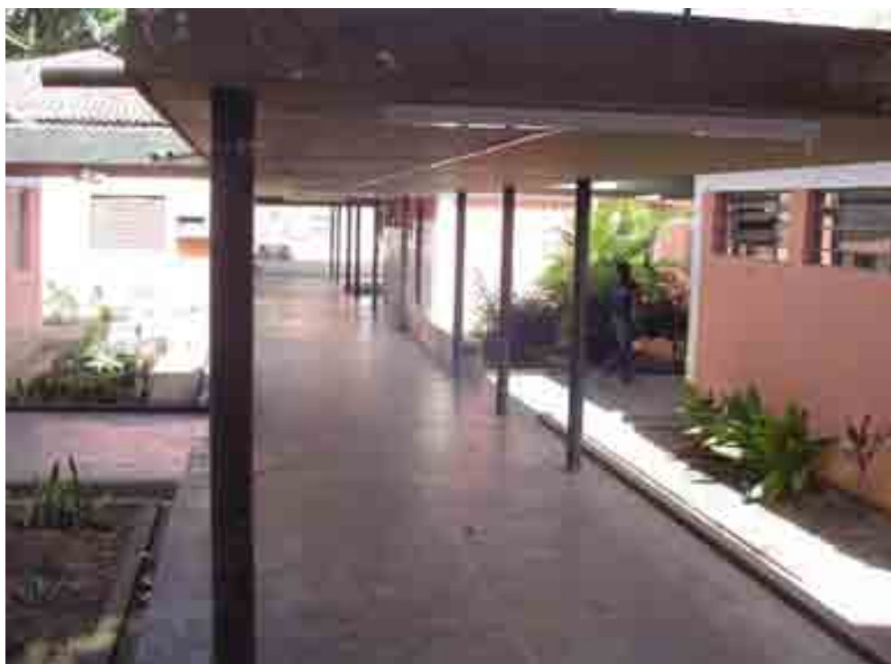
Figura 05: Foto da parte interna da EEFM Polivalente Modelo de Fortaleza
