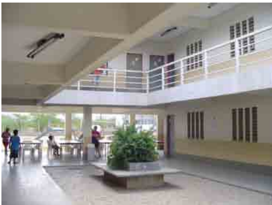
Figura 11: Foto da parte interna da EMEFM Raimundo Marques de Almeida
