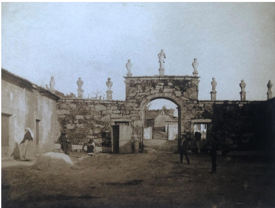
Figura 29: Reconstrução da Casa de Pascoaes, iniciada em 1911. Fonte: FERREIRA, 2002.
