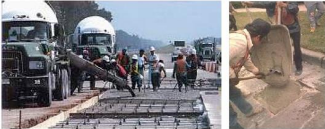
Figura 09 – Utilização do geopolímero Pyrament como material de reparos emergenciais
