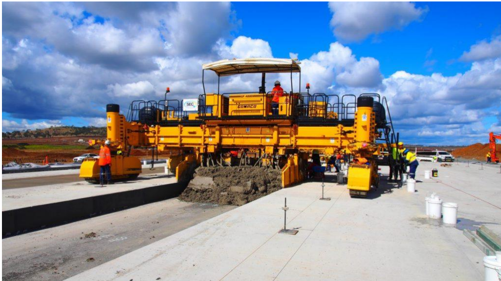
Figura 10 – Aeroporto BWWA em construção
