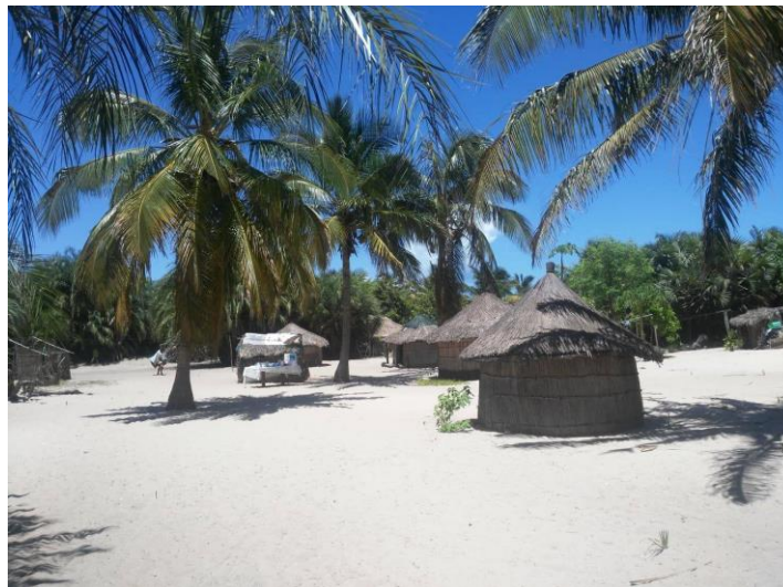
Figura 14: Casa de construção local
