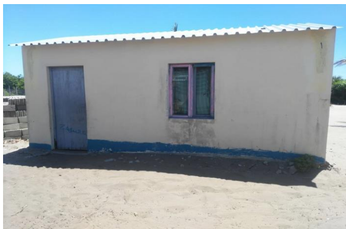
Figura 15: Casa construída no âmbito do reassentamento da comunidade
