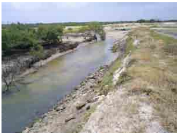
Foto 5.6: Construção de taludes de viveiros para empreendimento de carcinicultura nas proximidades do manguezal, provocando o barramento de canais de alimentação e drenagem do manguezal. Foto: Bruno Costa. (2008).
