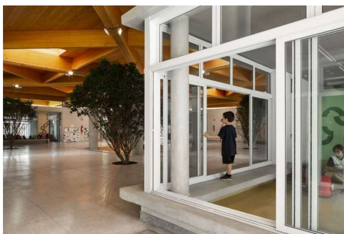
Figura 9: Janelas das salas de aula
