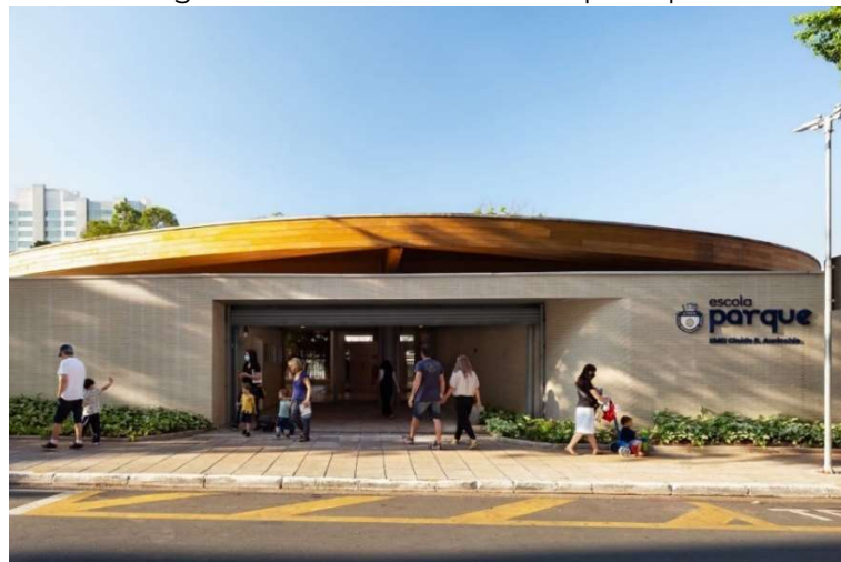
Figura 5: Fachada da entrada principal
