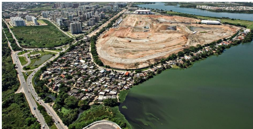
Figura 4,11: Imagem aérea da Vila Autódromo antes das obras do Parque Olímpico
