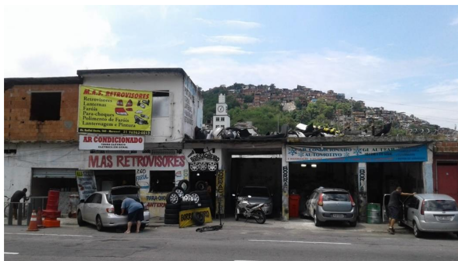
Figura 4,44: As oficinas de mecânicos na entrada da Favela do metrô (2)
