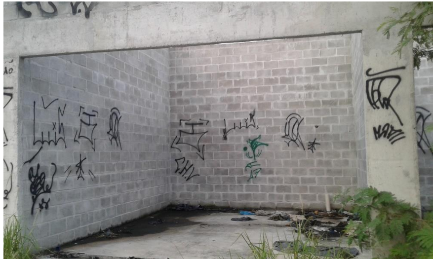
Figura 4,39: Os boxes abandonados construídos pela Prefeitura
