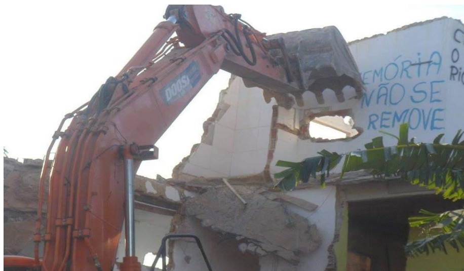
Figura 6,13: Demolições na Vila Autódromo
