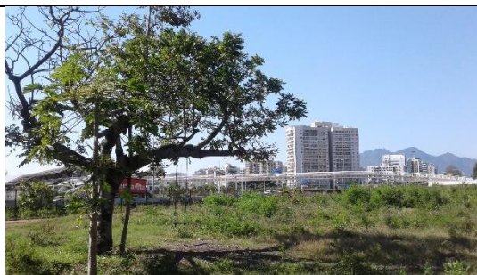
Figura A16: Passarela do BRT Vila Autódromo
