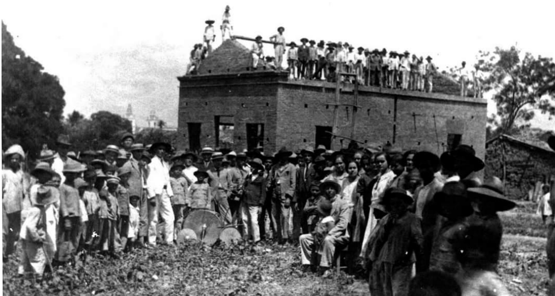
Figura 3: Construção da Capela de Nossa Senhora das Dores, século XIX.
