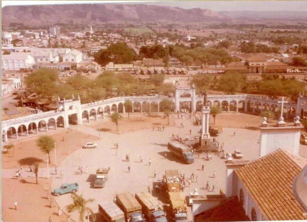
O passeio das almas que contorna a igreja do Franciscano, bairro de mesmo nome em Juazeiro do Norte - CE, final do século XX. Fonte: Cariri das Antigas.
