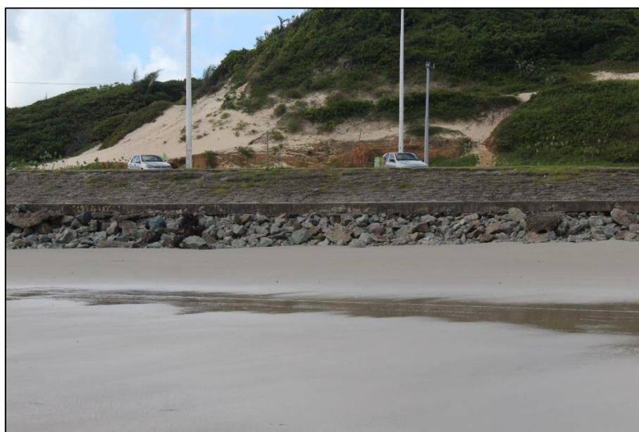
Figura 25 - Enrocamento na praia do Caolho.
