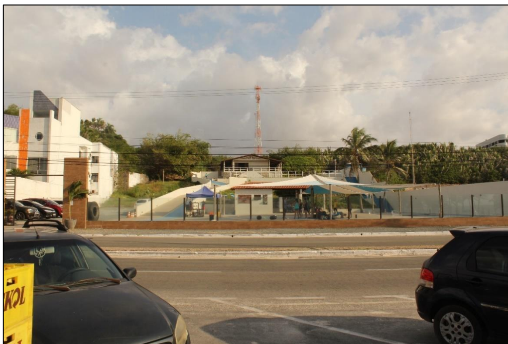
Figura 23 - Construção para a prática esportiva.
