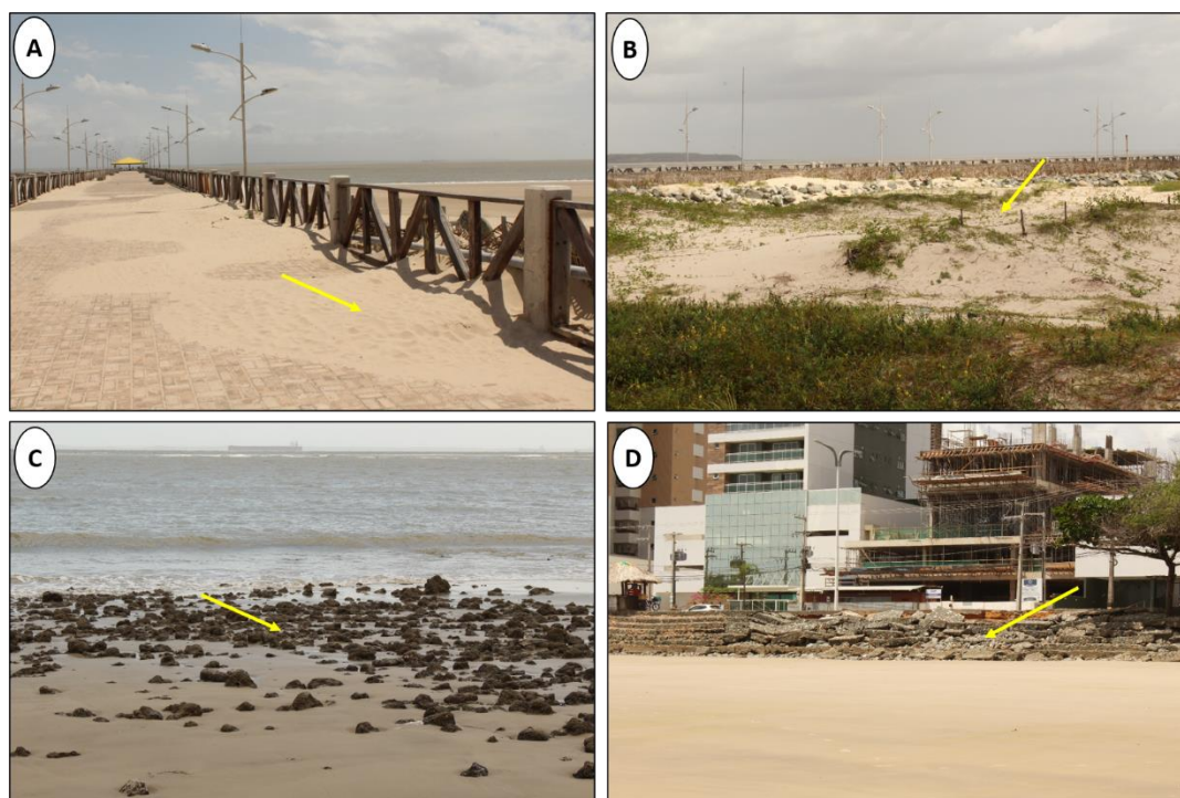
Figura 29 – A) Sedimentos acumulados no espigão; B) Dunas próximas ao espigão; C) Arenitos no estirâncio; D) Obra de contenção na orla erodida.
