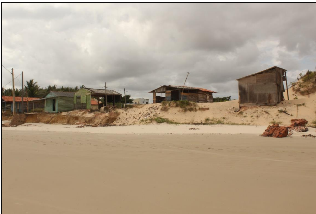
Figura 19 - Construções em área de dunas.
