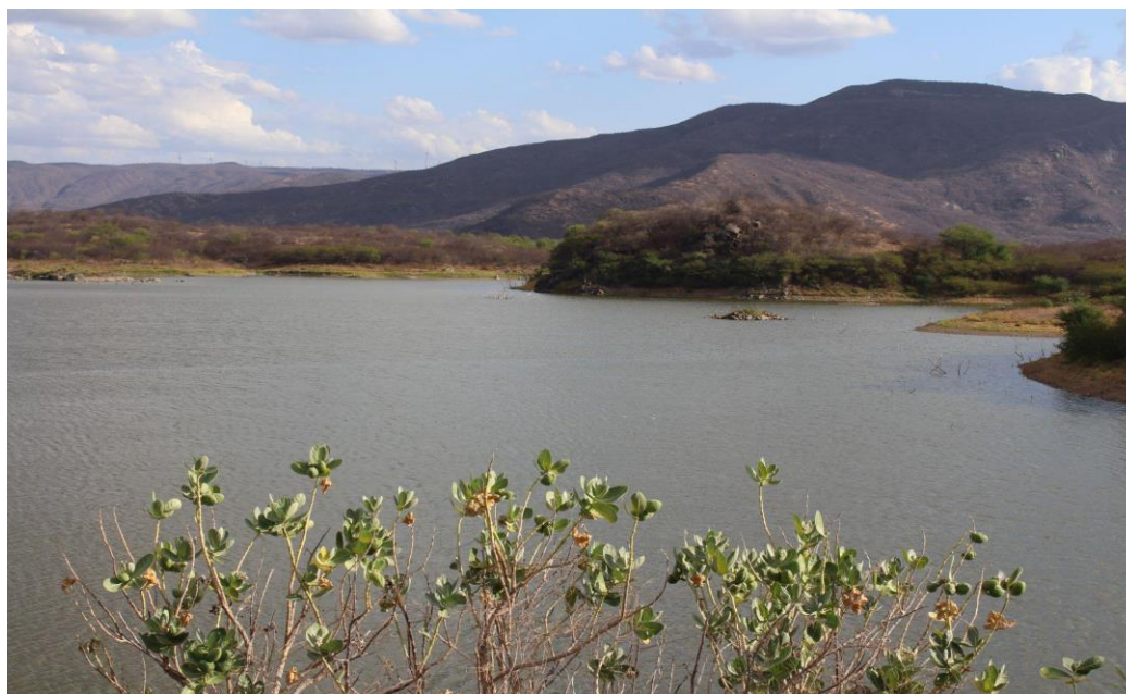
Figura 40. Reservatório Rio da Pedra
