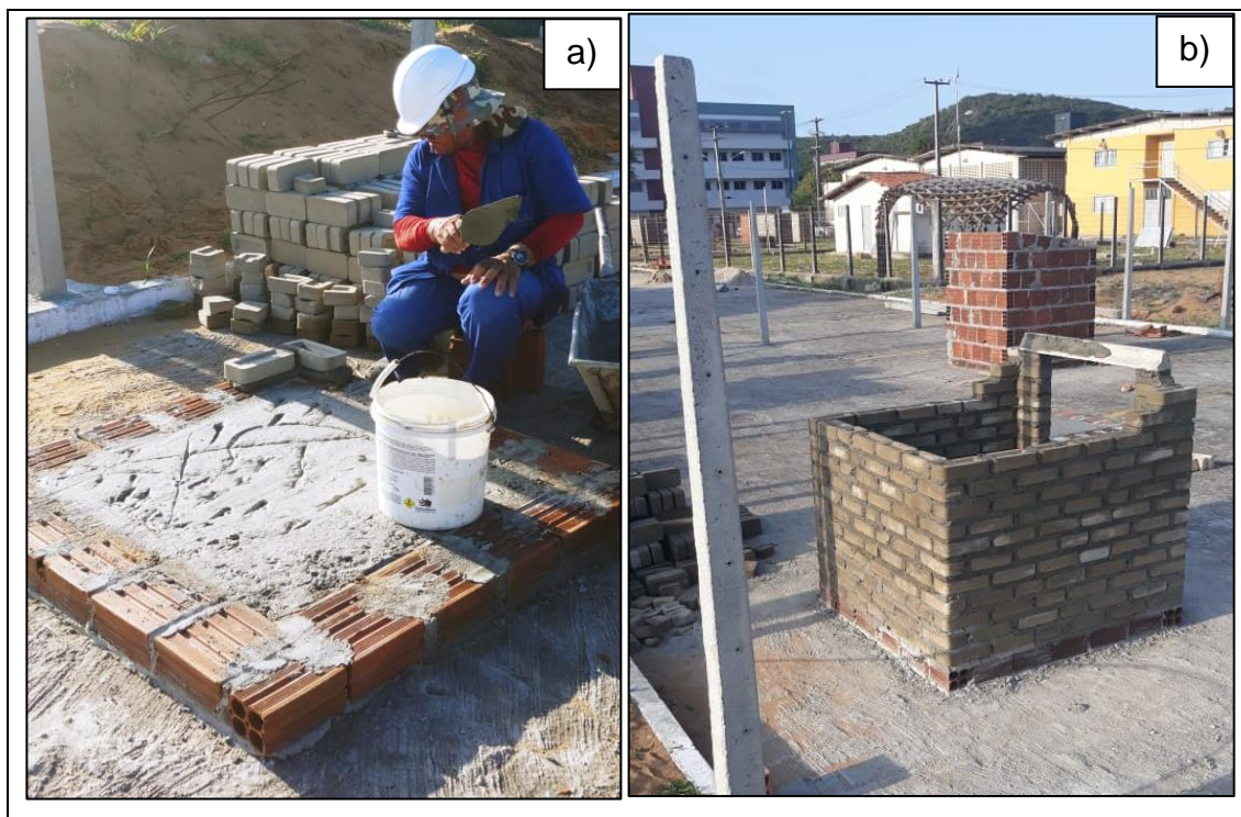
Figura 4.37 – Construção da casa protótipo de tijolos resíduo-cimento.
