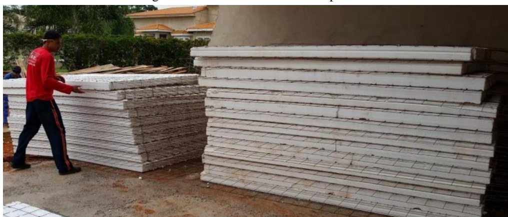
Figura 4.33 – Armazenamento dos painéis
