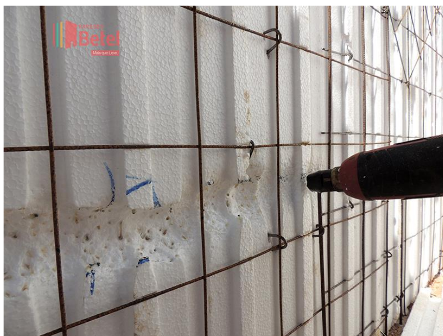
Figura 2.27 - Abertura no painel para instalações complementares
