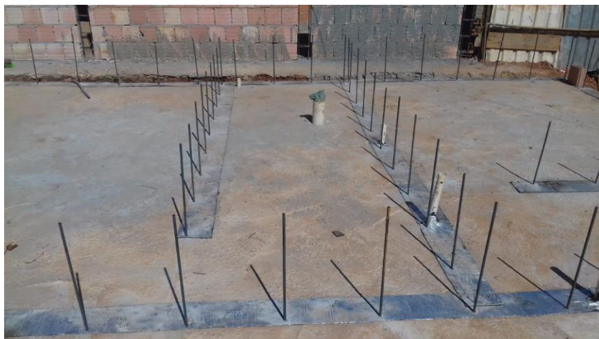
Figura 2.23 – Fixação dos arranques
