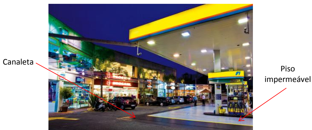
Figura 2.24. Piso impermeável e canaletas.
