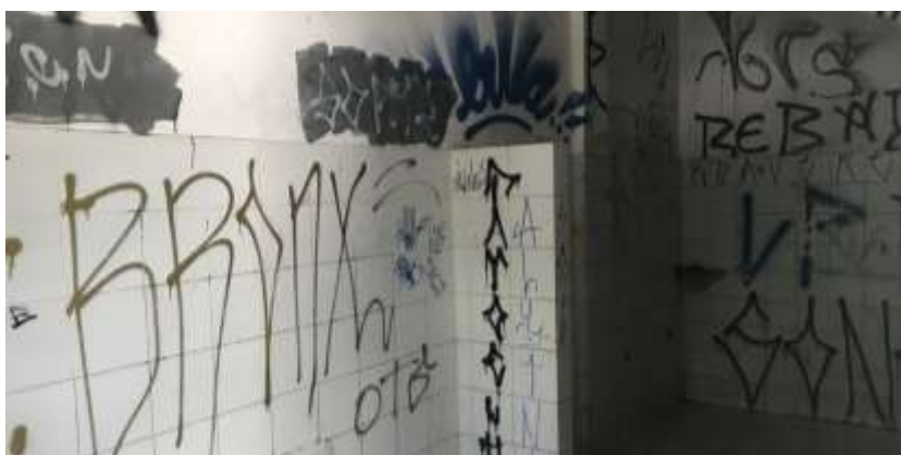
Figura 73: Interior dos banheiros do PEC
