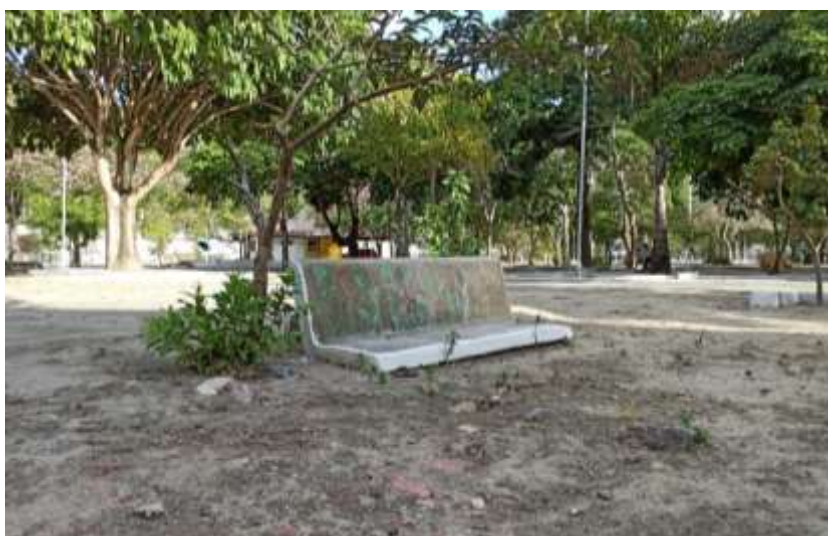
Figura 62: Bancos deteriorados no Parque Evaldo Cruz
