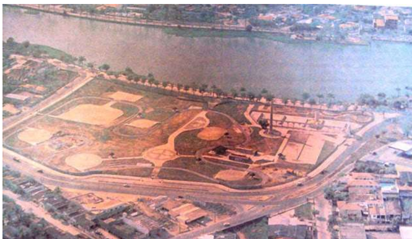
Figura 95: Parque da Criança sendo construído em 1993
