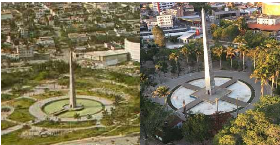
Figura 100: Antes e depois da fonte luminosa, após reforma em 2002
