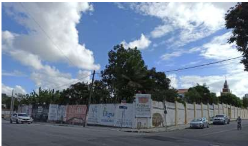
Figura 50: Muro do Convento das Clarissas
