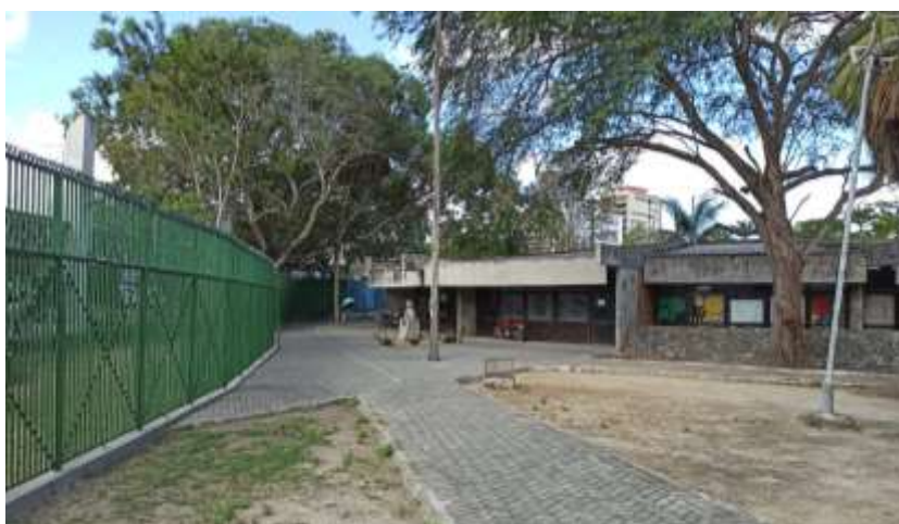
Figura 53: Grade que determina o limite da área do terminal e perpassa toda a fachada norte do parque
