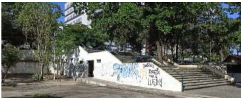
Figura 72: Entrada dos Banheiros na escadaria principal do PEC
