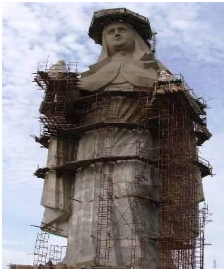
Figura 15 – Monumento de Santa Rita de Cássia em construção.
