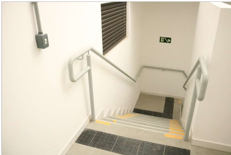
Figura 3.54 - Escada com corrimão com devido prolongamento e sinalização de saída de emergência.
