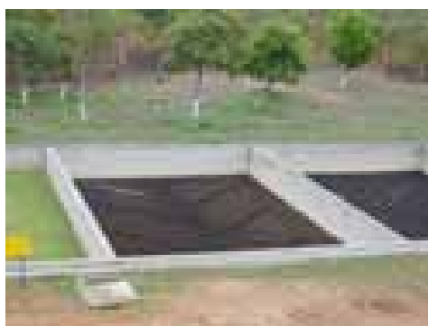
Figura 5.10 – Tratamento do lodo biológico em leitos de secagem
