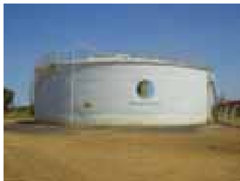
Figura 5.7 – Tratamento Biológico em Reator UASB
