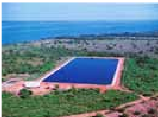
Figura 5.9 – Lagoa Facultativa da ETE
