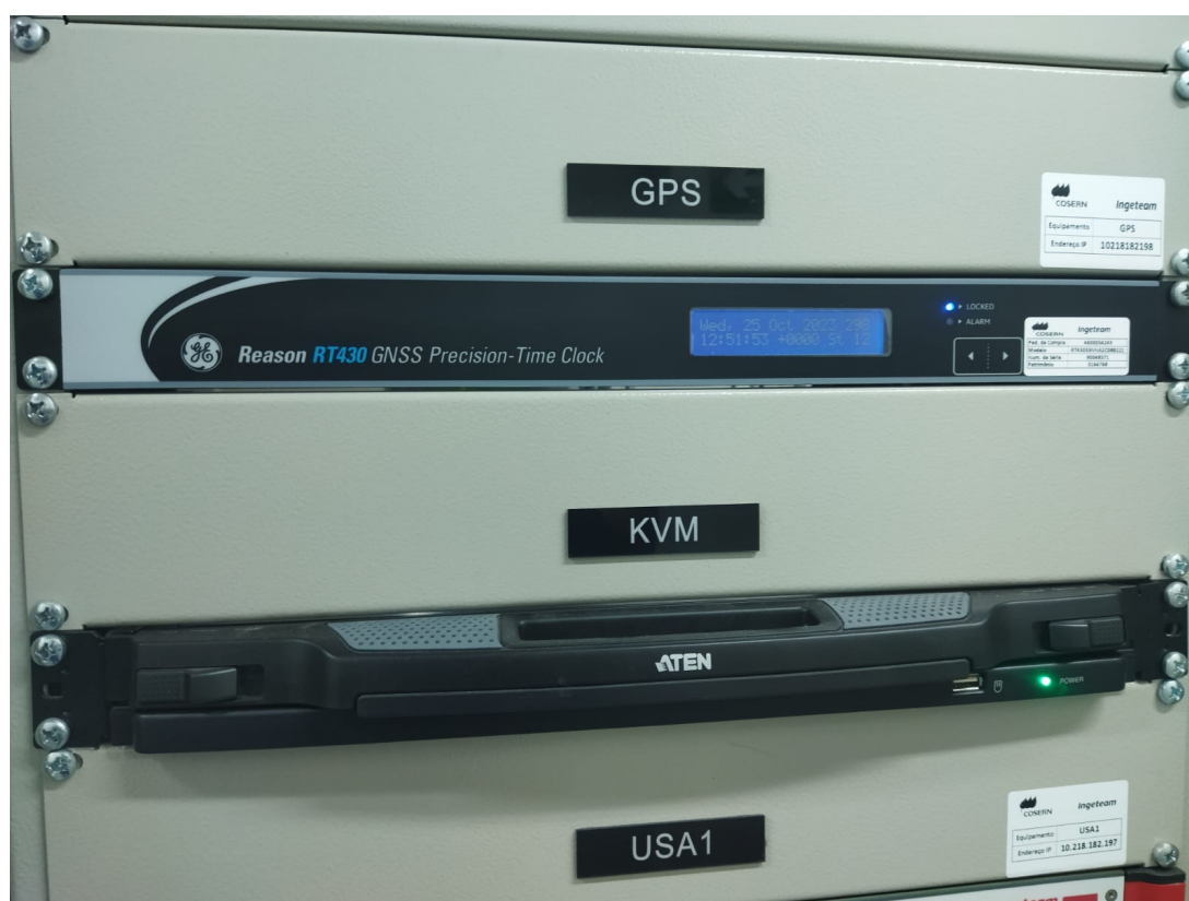
Figura 50 – GPS para sincronização de horários e KVM para acompanhamento do SAGE nível 2.
