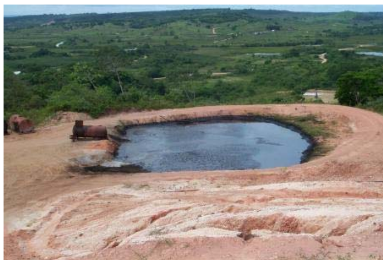
Figura 2.1 – Dique alto do Morro de Jericó/SE em 2002 (Alves, 2003).
