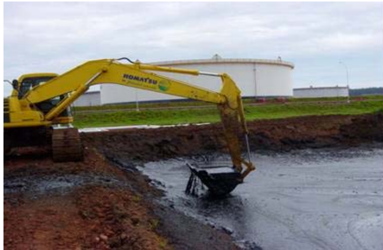
Figura 2.6 – Remoção da borra oleosa do Landfarming na REPLAN para acondicionamento em tambores no pátio de resíduos e para posterior co-processamento.
