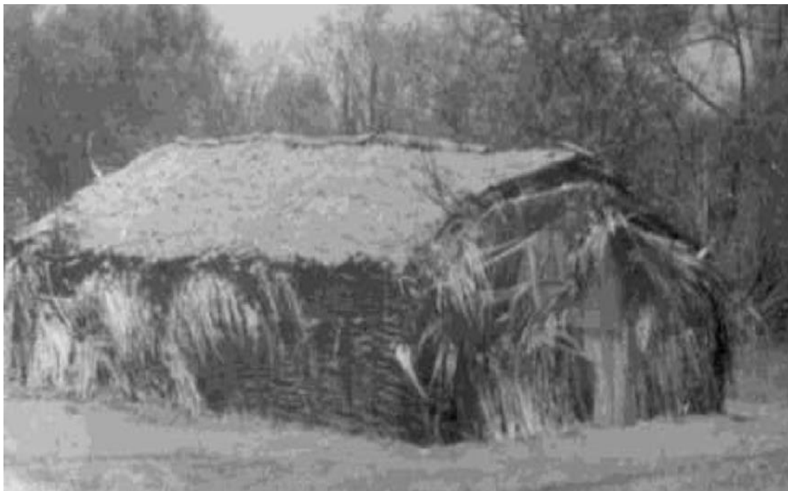
Figura 16: Casa em que residia D. Maria Vieira, mãe de Chica Vieira. Esse registro evidência que a arquitetura à base de taipa e palha ainda era usada na Boa Vista durante a década de 1980. Fonte: OLIVEIRA JÚNIOR, 2017, p. 373.
